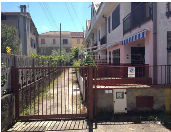
FOTO N.1: VIALE DI ACCESSO CIVICO N.5
