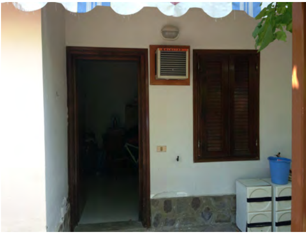
FOTO N.7: INGRESSO PIANO TERRA
