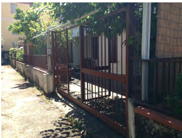
FOTO N.3: INGRESSO AL SUB 13
