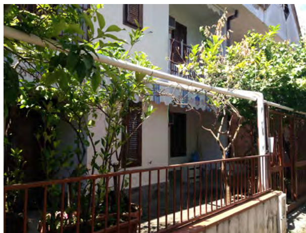
FOTO N.4: CORTE PAVIMENTATA SUB 13
