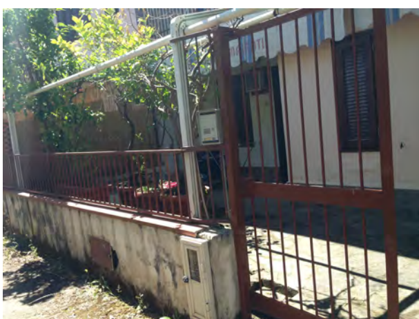
FOTO N.5: CORTE PAVIMENTATA SUB 13
