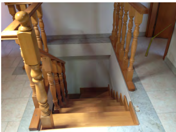
FOTO N.25: SCALA DI ACCESSO AL SOTTOTETTO
