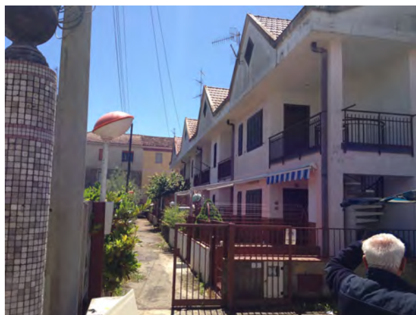
FOTO N.2: VIALE DI ACCESSO CIVICO N.5
