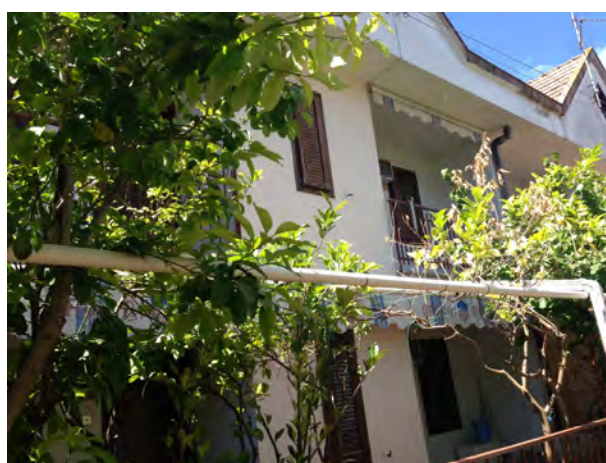
FOTO N.6: PROSPETTO PRINCIPALE SUB 13
