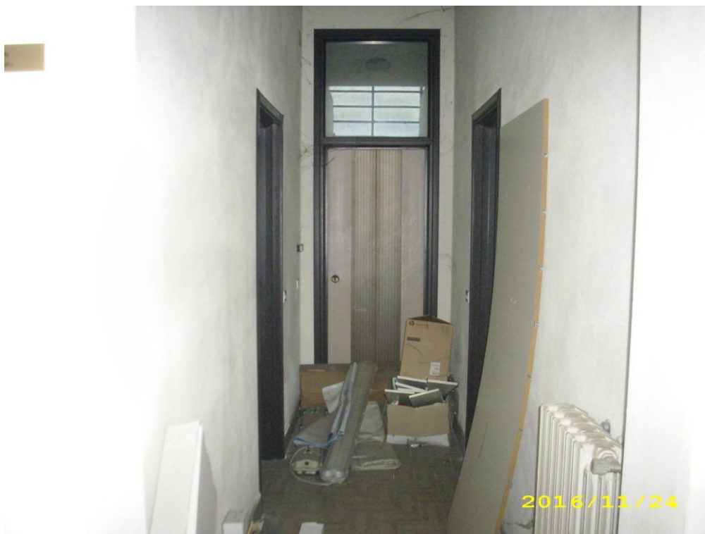
FOTO N. 14 – Disimpegno servizi igienici
