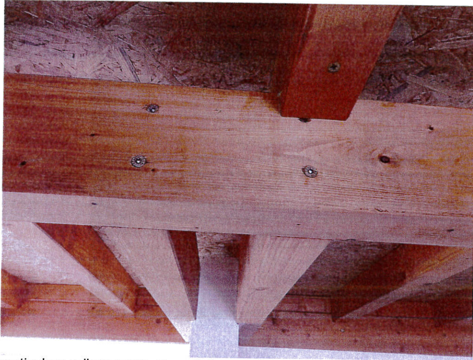
particolare collegamento mensola trave esterna
