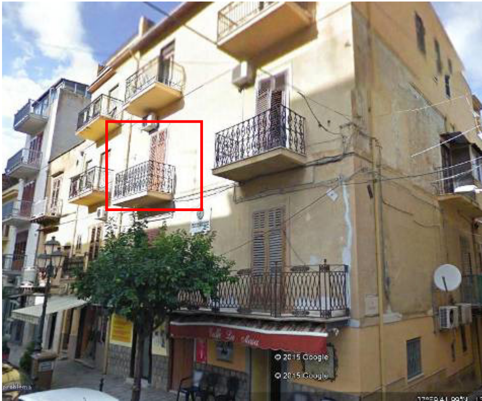
Foto n. 1 – Prospetto su via La Masa
