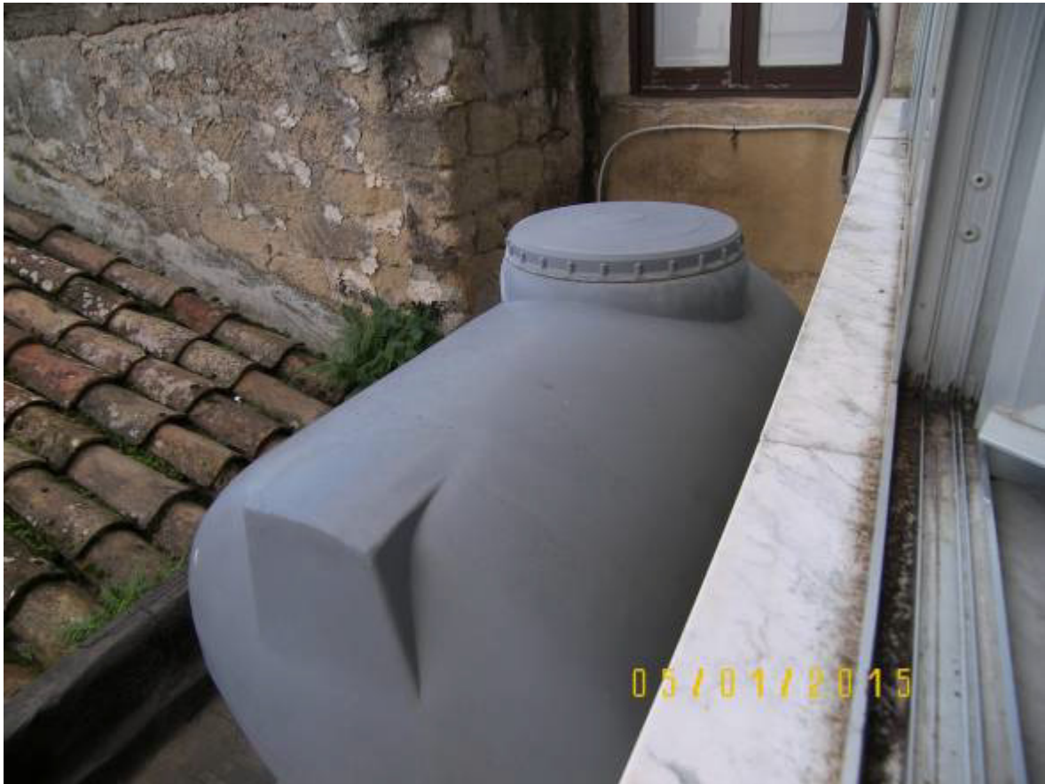
Foto n. 12 – Riserva idrica collocata sul prospetto posteriore (lato vicolo Militello)
