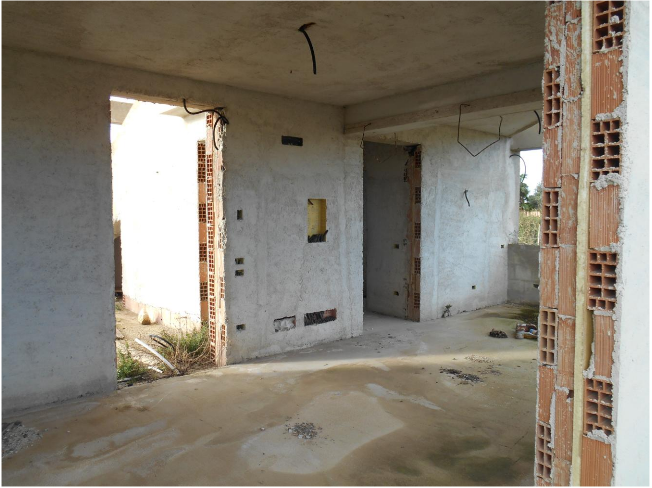
Piano terra Sud-Ovest 1
