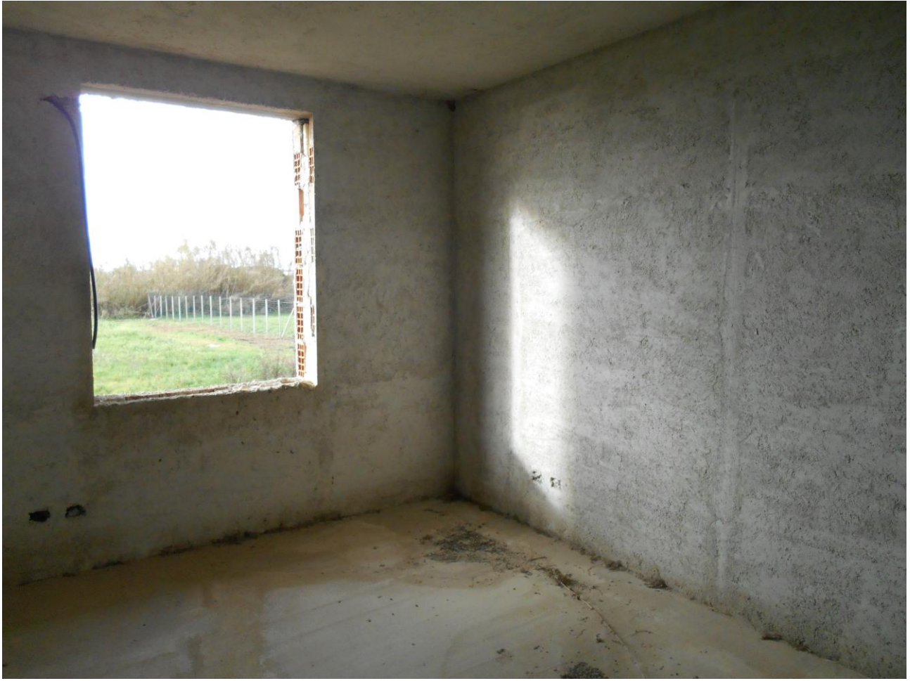
Piano terra - Sud 1
