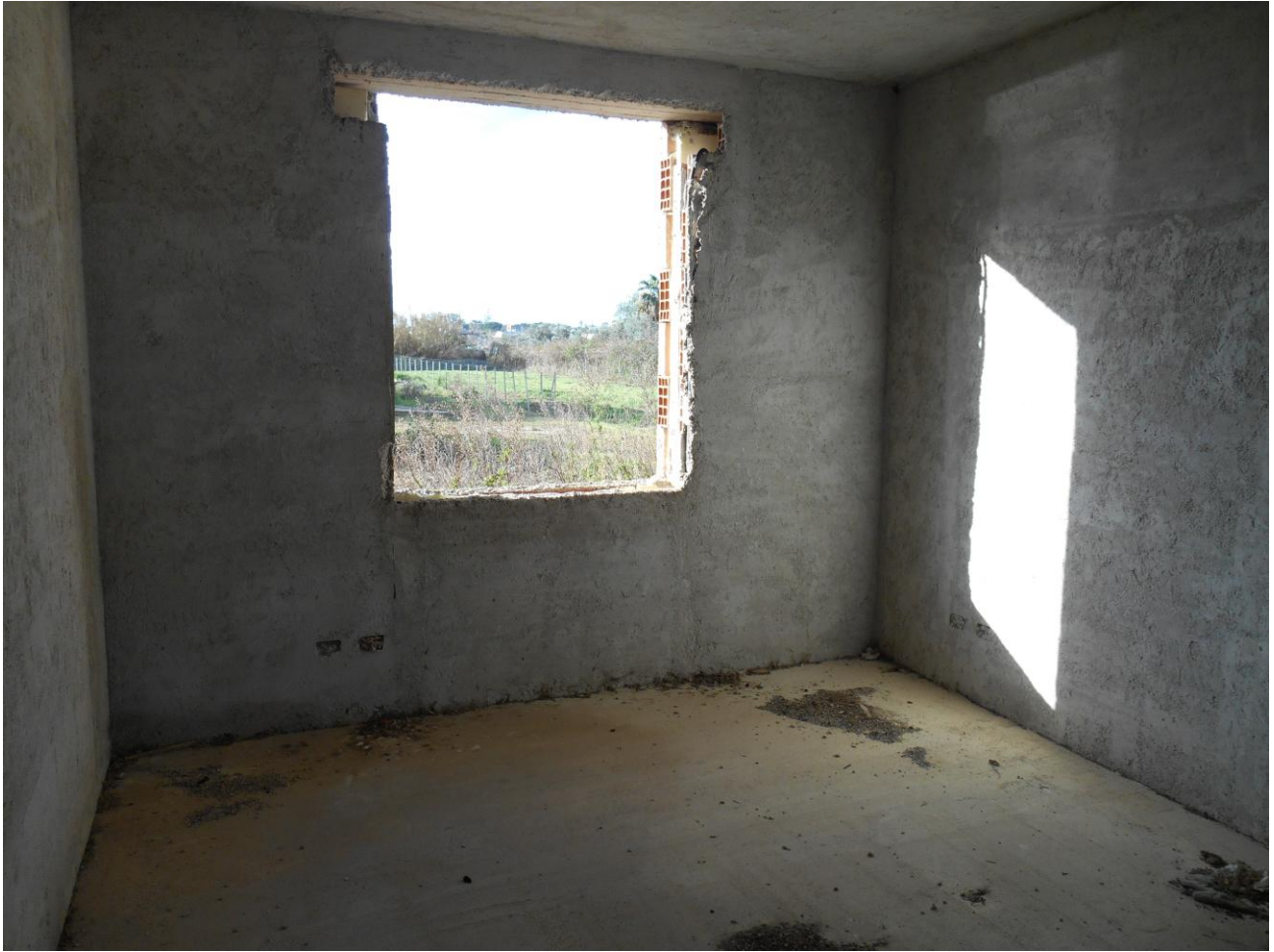
Piano terra Sud 2
