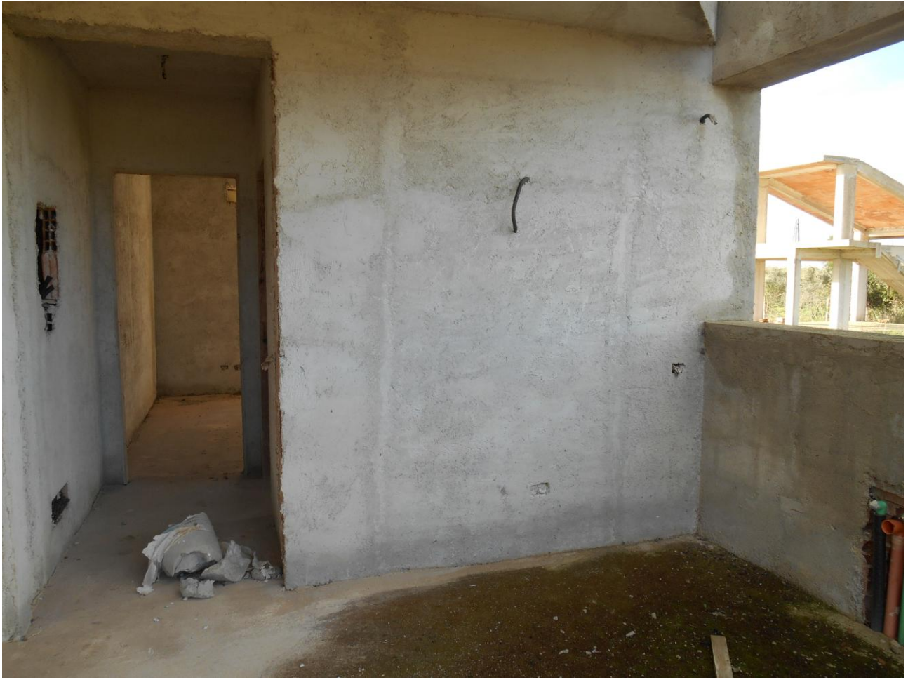
Piano terra Sud 2
