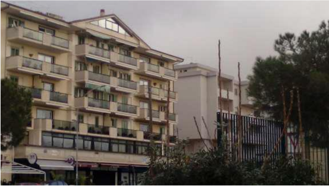
Foto 1 – Foto esterna dell'immobile su via Resistenza Partigiana
