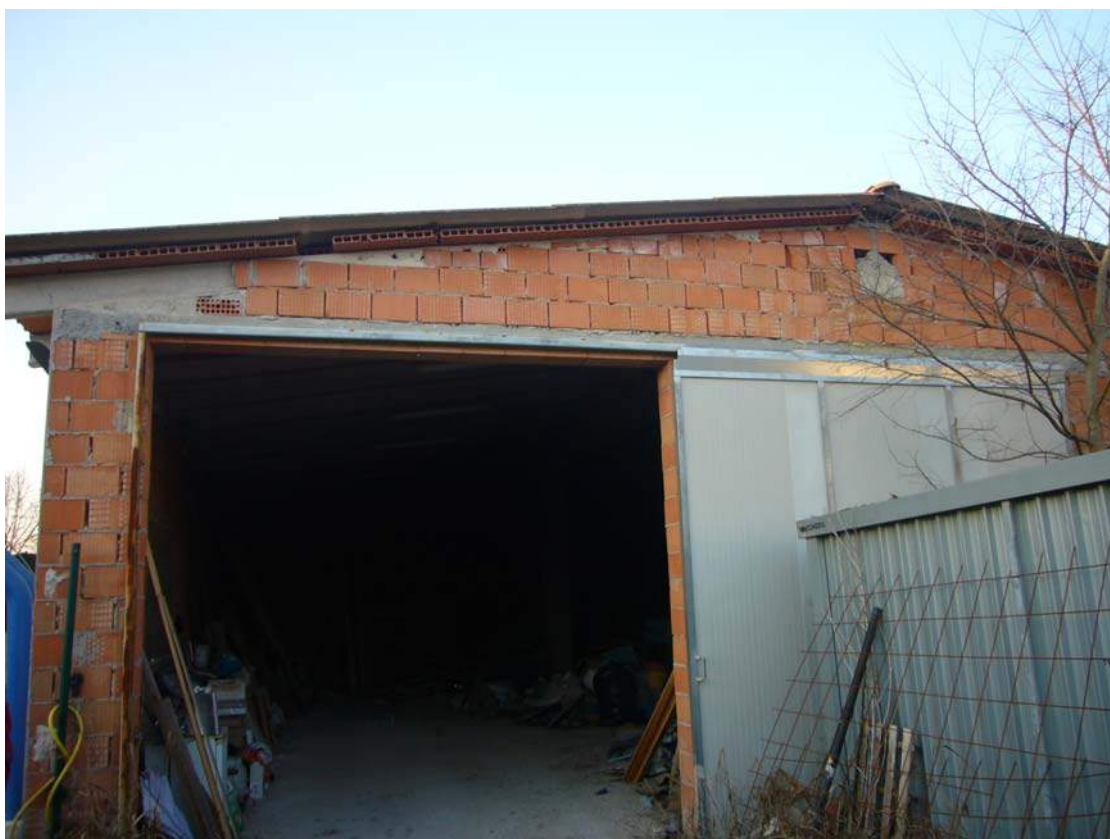
FOTO 2 – Esterno del deposito (Bene 7)
