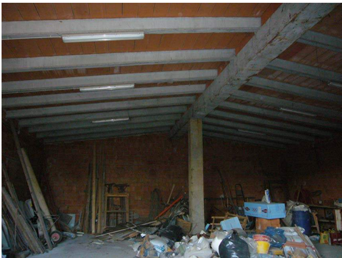
FOTO 4 – Interno del deposito (Bene 7)
