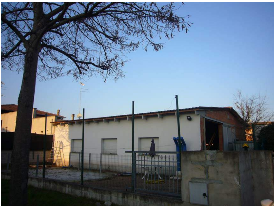
FOTO 3 – Esterno del deposito (Bene 7)
