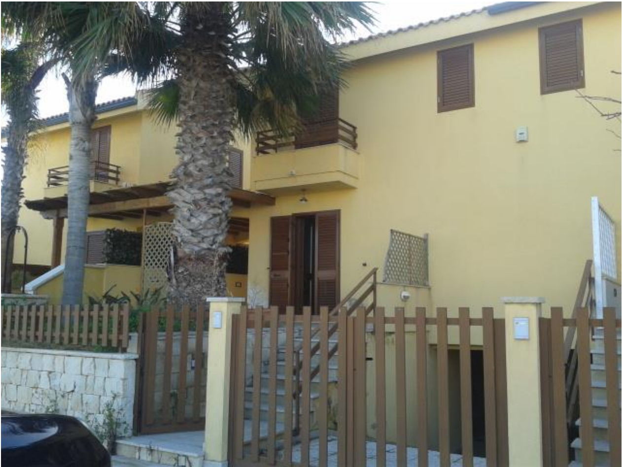
Figura 1 - Ingresso all'unità residenziale dal cancelletto pedonale sulla veranda di pertinenza esclusiva
