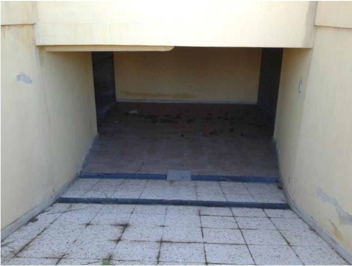
Figura 9 - Scivolo comune di accesso al garage sotto strada
