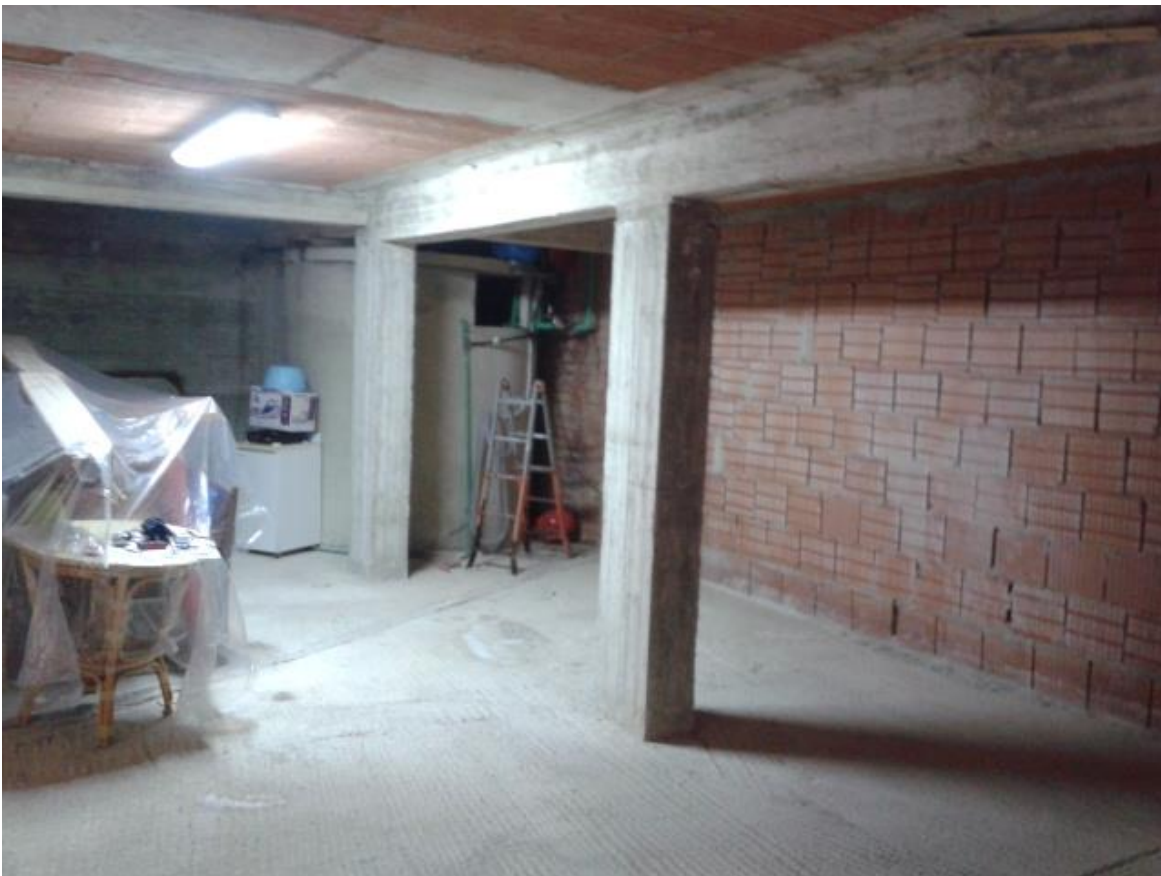
Figura 10 - Garage sotto strada
