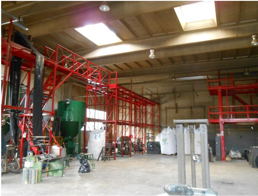
vista interna capannone B
