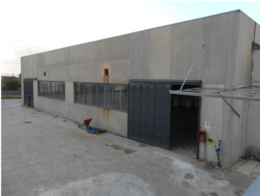
vista del fronte sud
