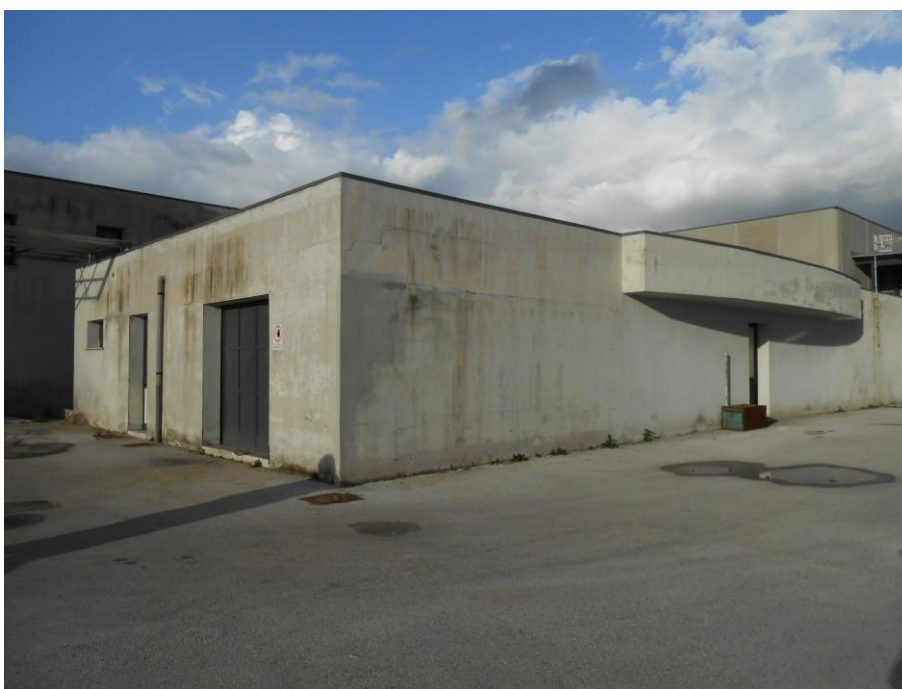
vista del fronte sud-ovest
