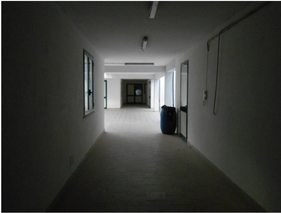
vista degli ambienti interni PT
