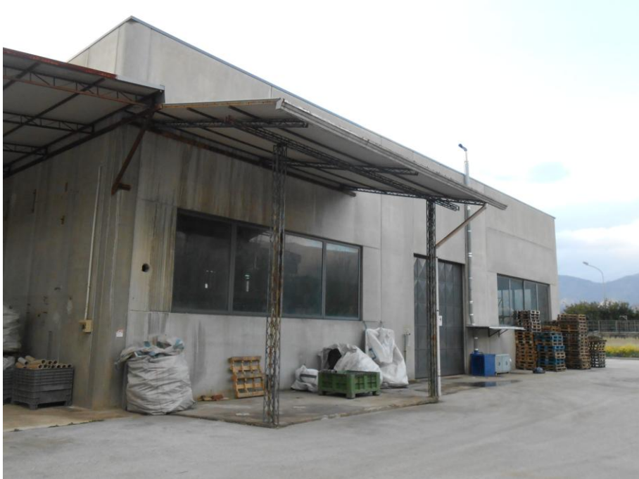
vista del fronte est
