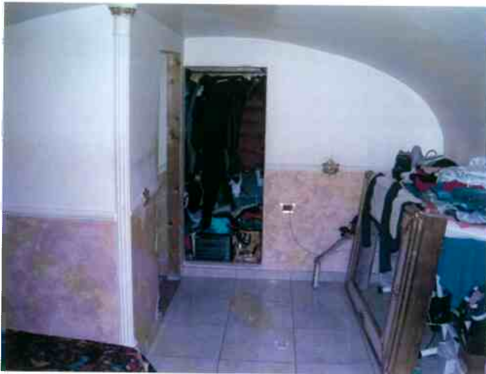
FOTO N. 9 – Porzione unità i. 1: piano soppalcato
