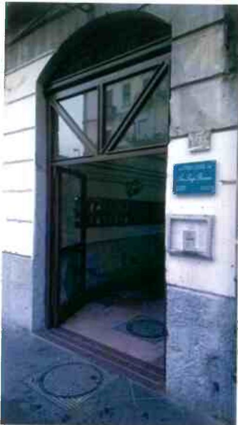
FOTO N. 15 – Portone stabile in via Arenaccia, 173
