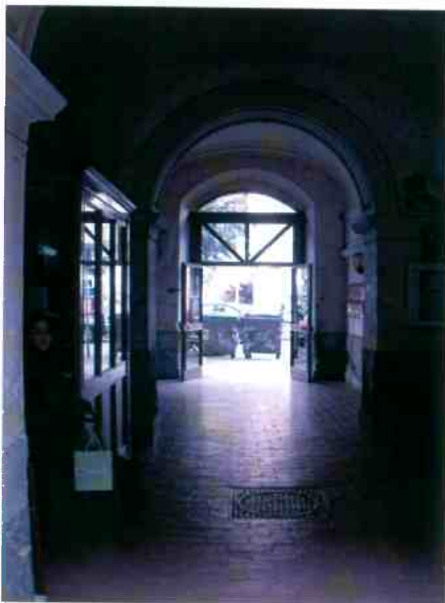
FOTO N. 16 – Androne stabile in via Arenaccia, 173
