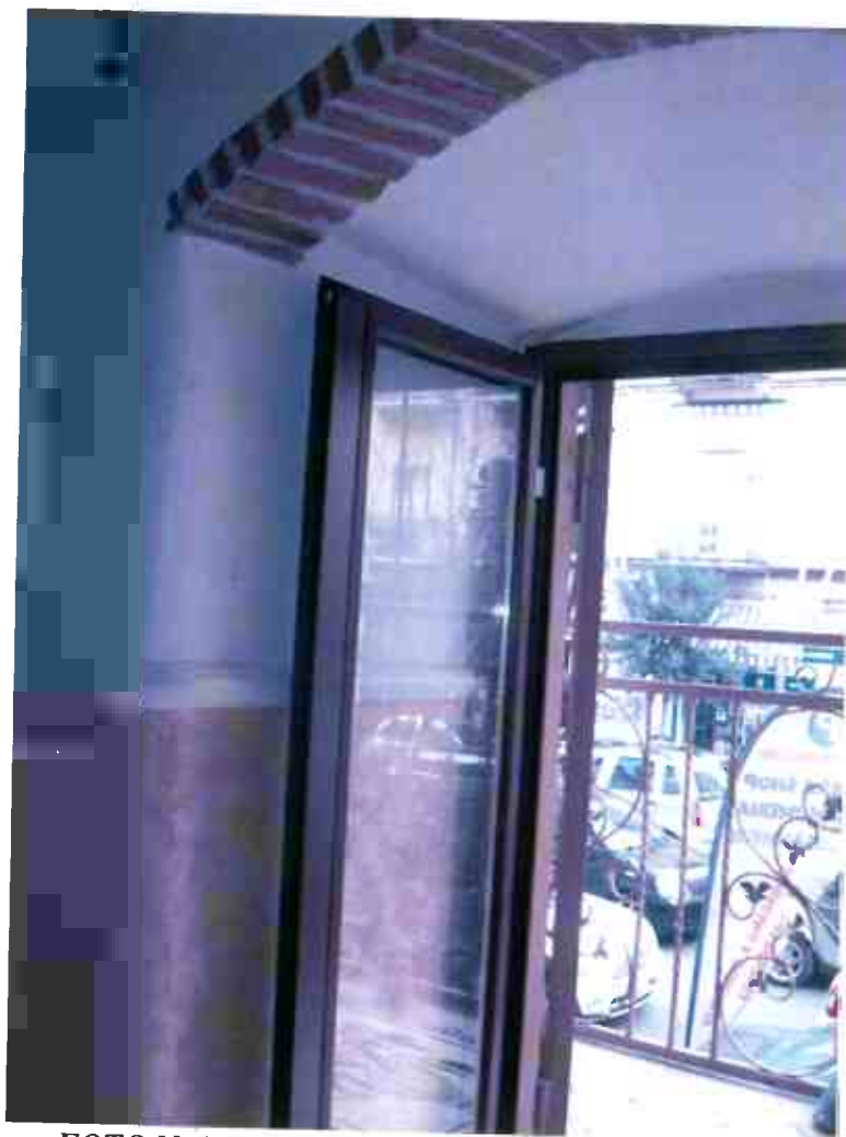
FOTO N. 12 – Porzione unità i. 1: accesso al balcone
