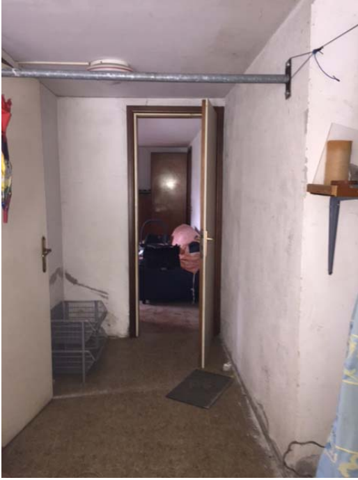
Accesso a Lavanderia da garage
