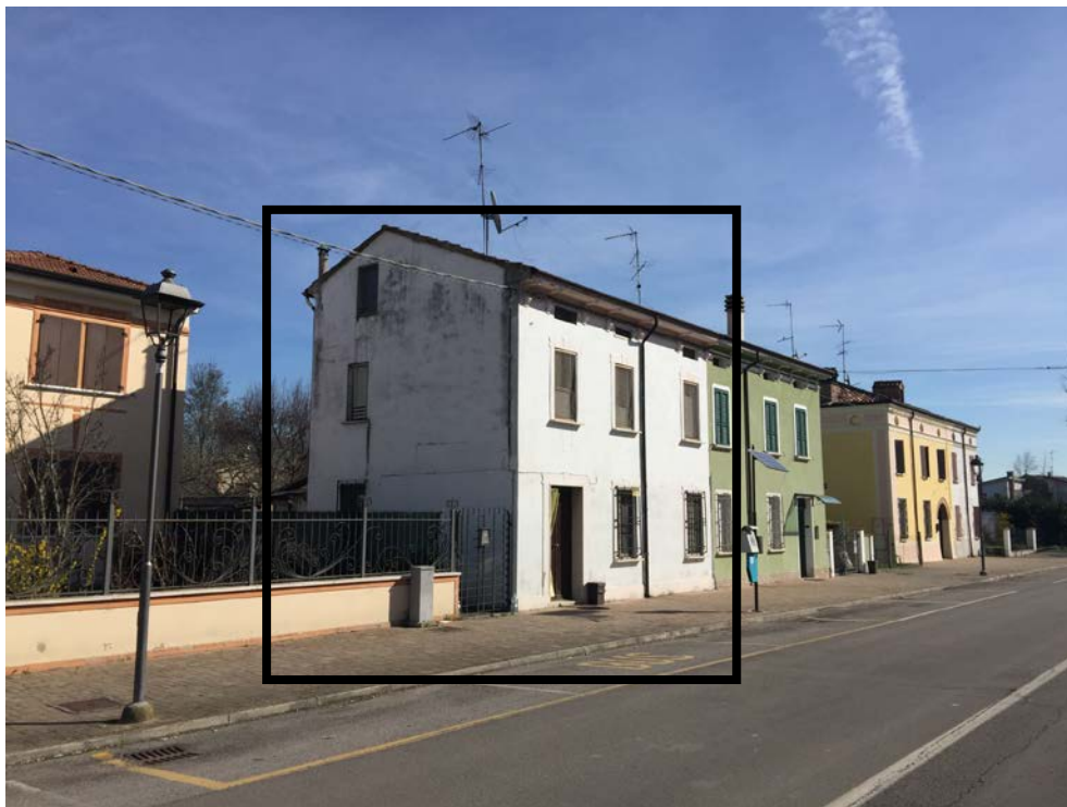
VISTA DA VIA ROMA n° 53
