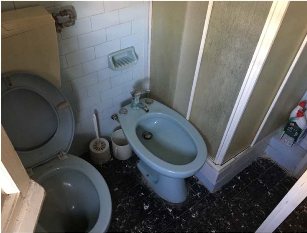
BAGNO – PIANO PRIMO
