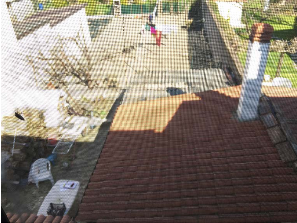
VISTA DALL ALTO DEL GIARDINO INTERNO
