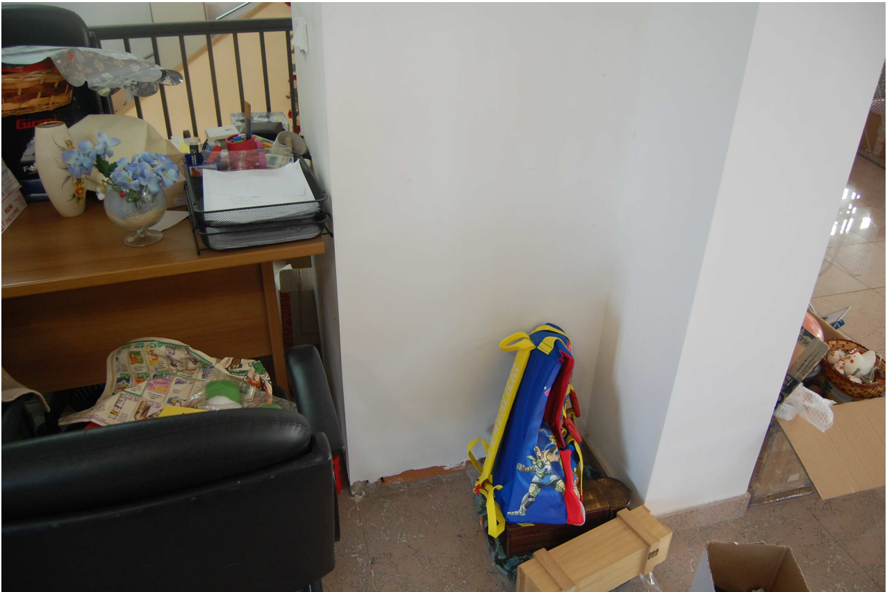
Foto 12 : Immobile piano primo: canna fumaria incassata da mattoni forati
