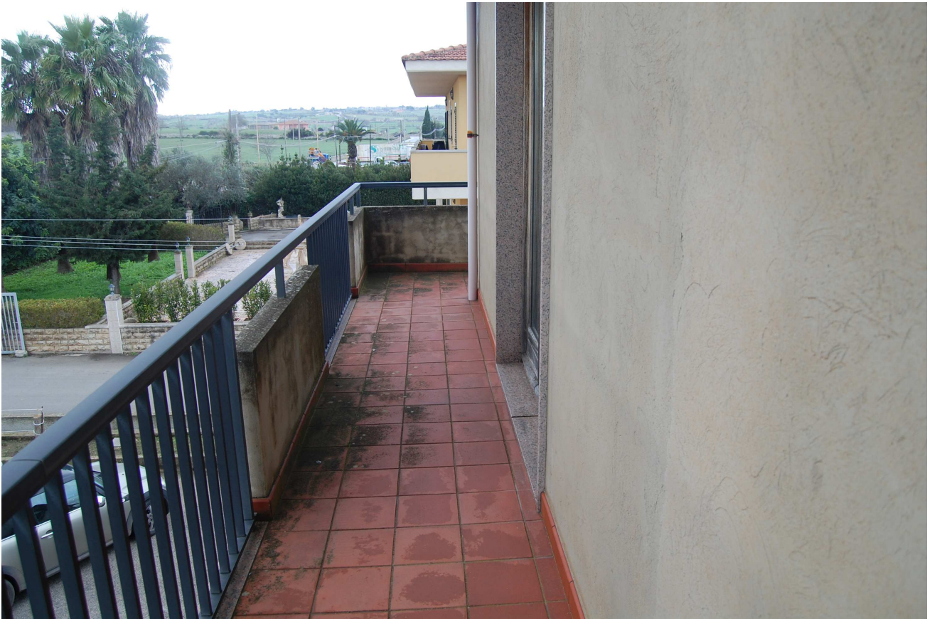
Foto 14: Balcone a ornamento del piano primo
