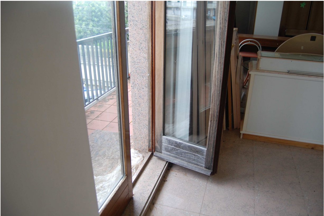
Foto 10 : Particolare infissi esterni
