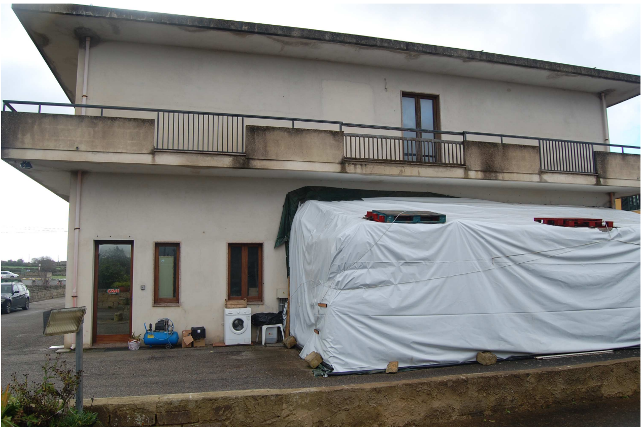
Foto 9 : Manufatto in corrispondenza del prospetto nord del fabbricato
