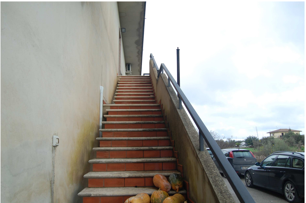
Foto 13 : Scale esterne di accesso al piano primo
