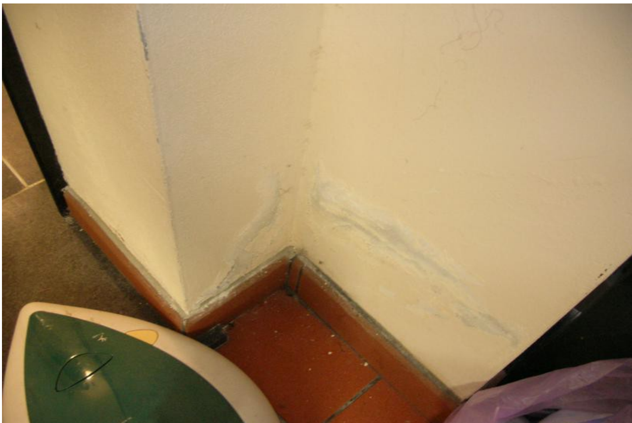
FOTO N. 14 - Descrizione: Particolare umidità di risalita nel garage
