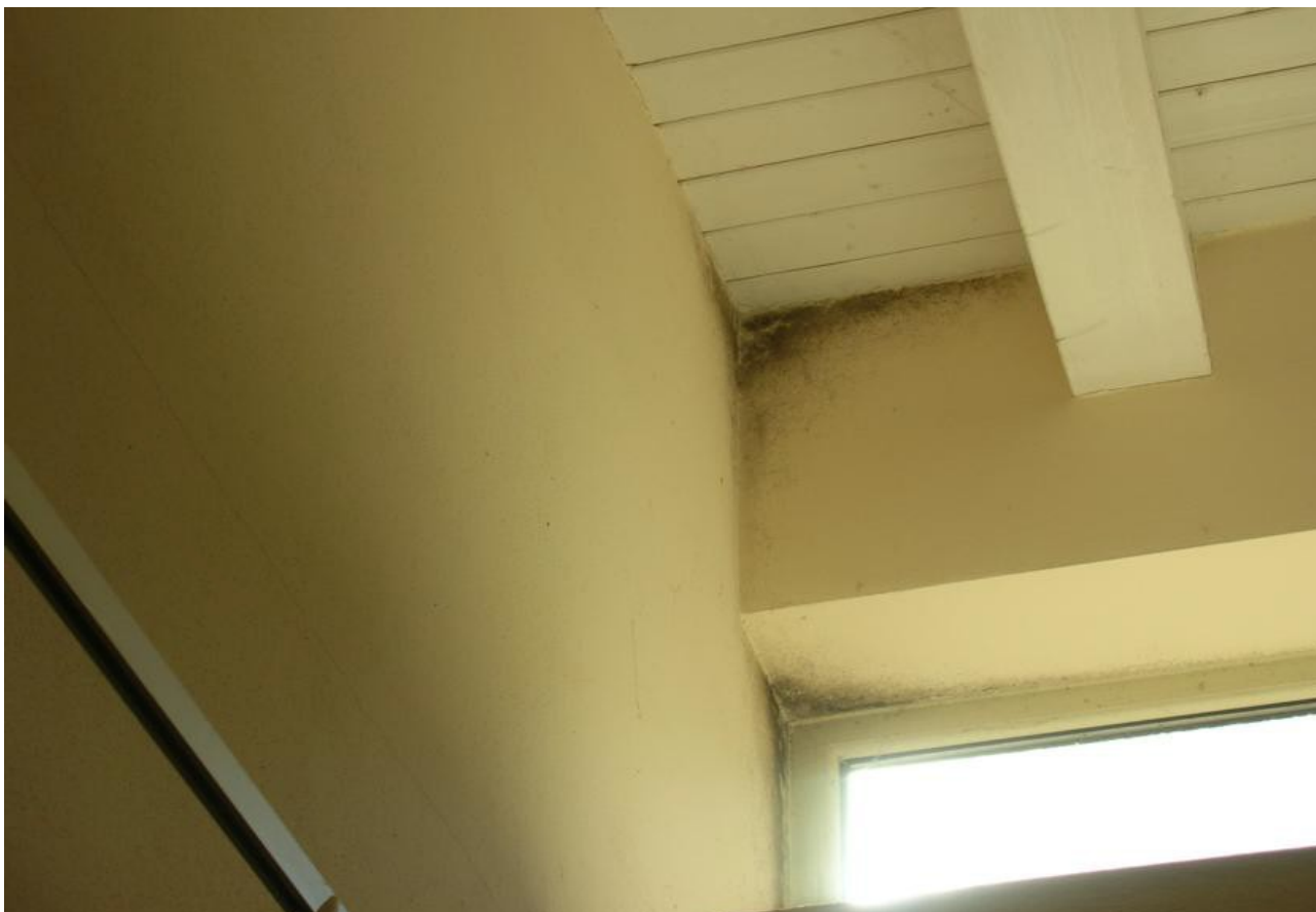
FOTO N. 14 - Descrizione: Particolare umidità di risalita nel garage
