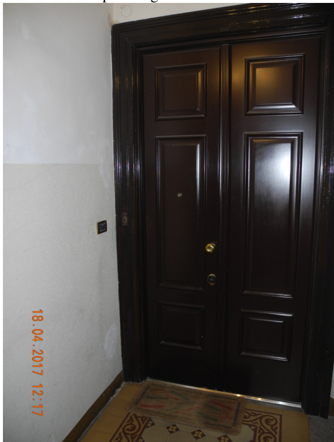
FOTO 6 – porta ingresso unità immobiliare
