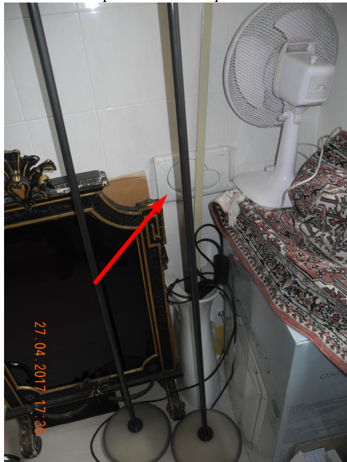
FOTO 16 – vano predisposto come bagno-w.c.; notare pulsantiera sciacquone
