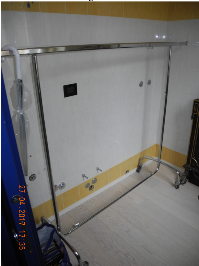
FOTO 14 – vano guardaroba, già predisposto come bagno-w.c.
