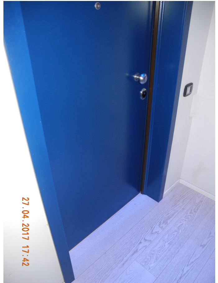
FOTO 33 – terza unità abitativa interna; ingresso da corridoio comune
