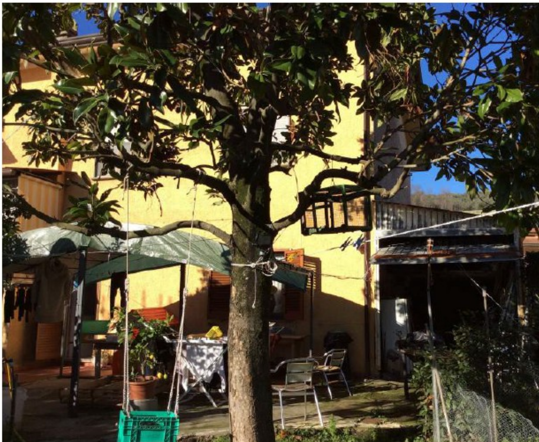
FOTO 5: Vista del fronte Nord-Est dell'edificio, posto su resede interna.
