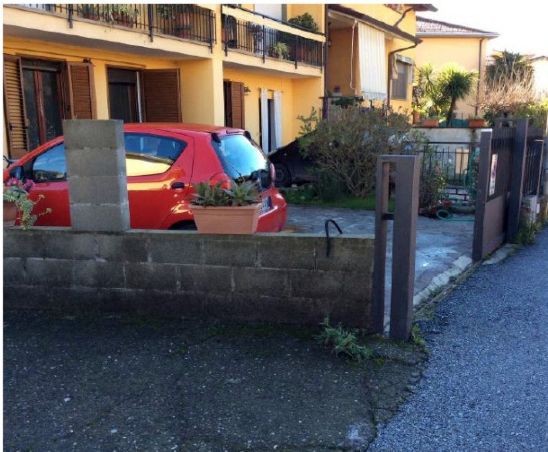
FOTO 3: Particolare della resede con relativa recinzione su Via Sterpeti.
