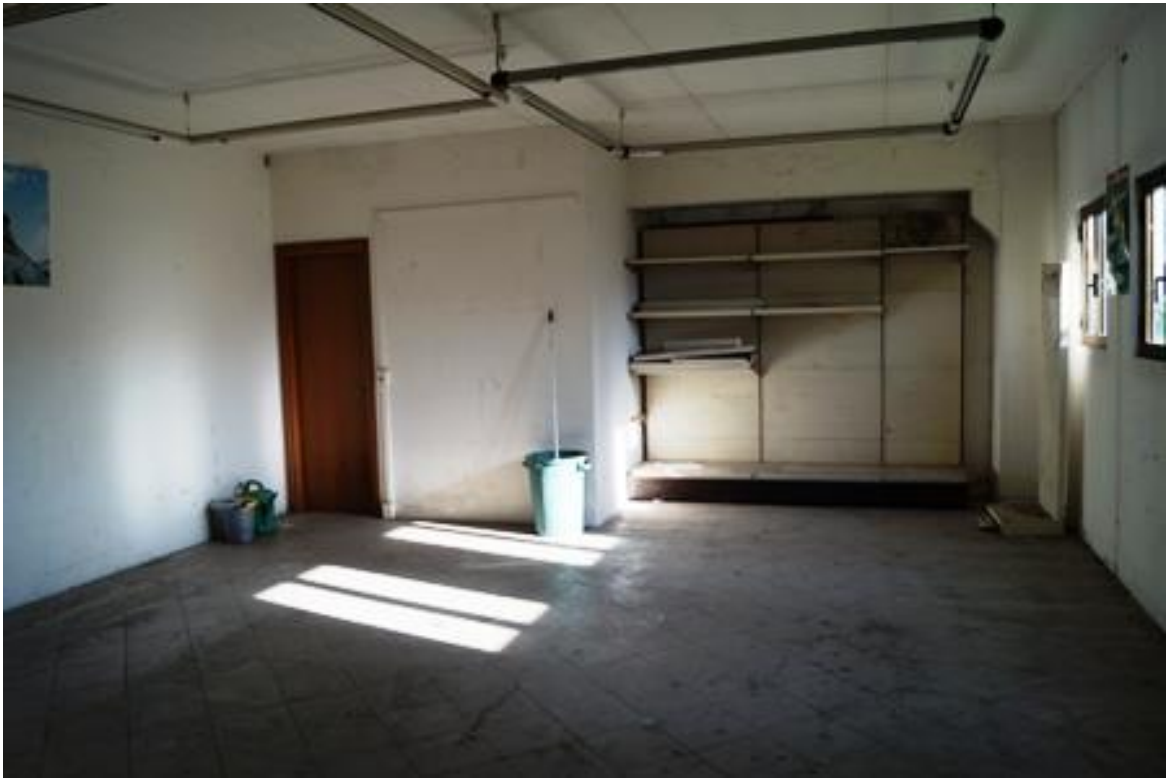
FOTO 21 RIPOSTIGLI P.T. –Fabbricato 3
