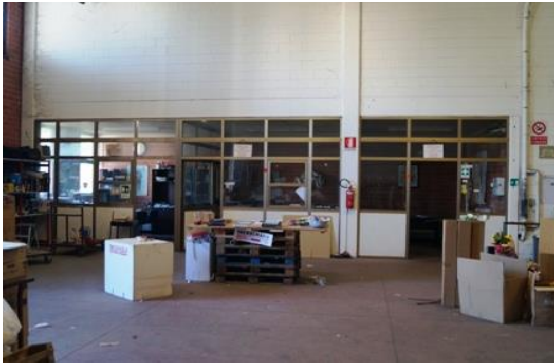
FOTO 9 LOCALI UFFICI P.T. – Fabbricato 1
