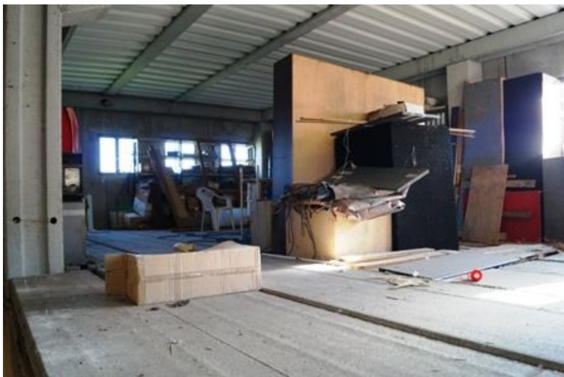
FOTO 24 RIPOSTIGLIO P.1° - Fabbricato 3
