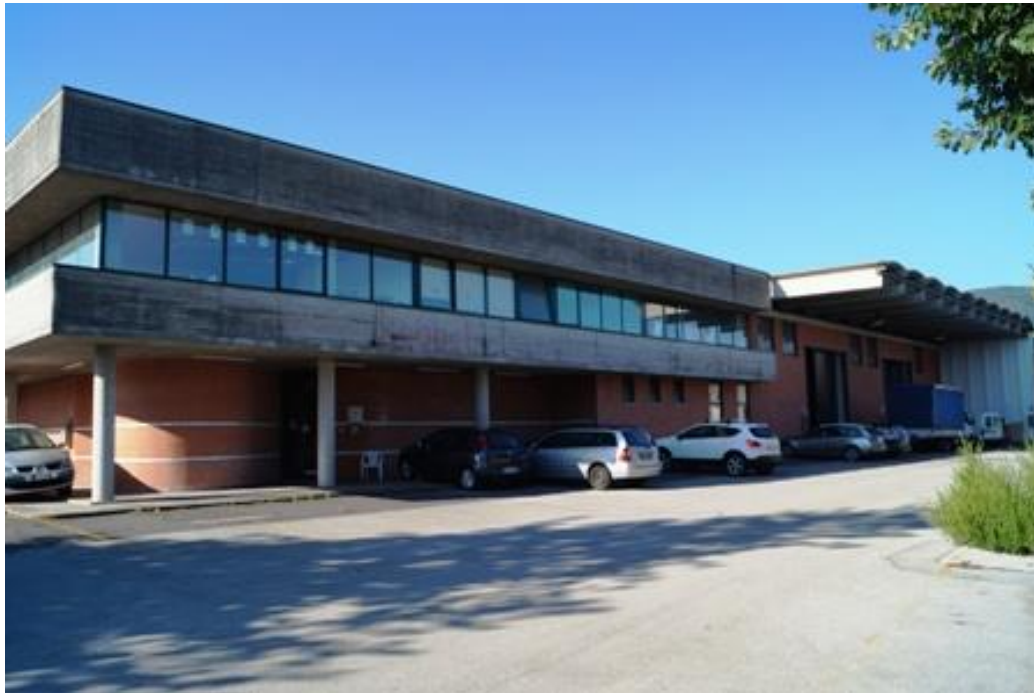
FOTO 3 ESTERNO – Fabbricato n. 1
