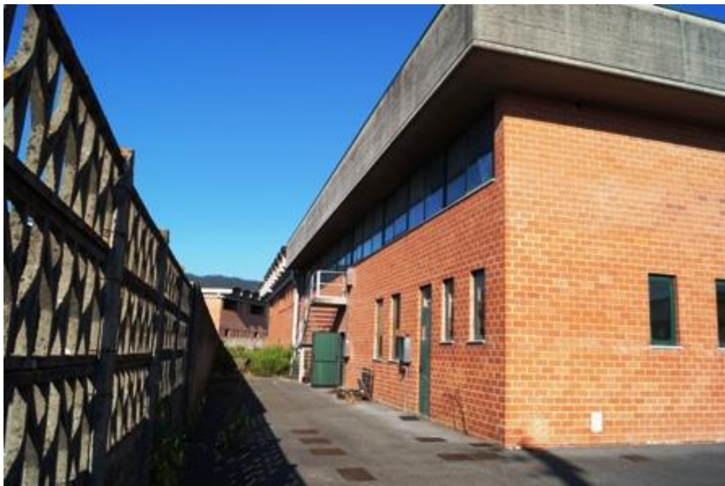
FOTO 4 ESTERNO- Fabbricato n. 1
