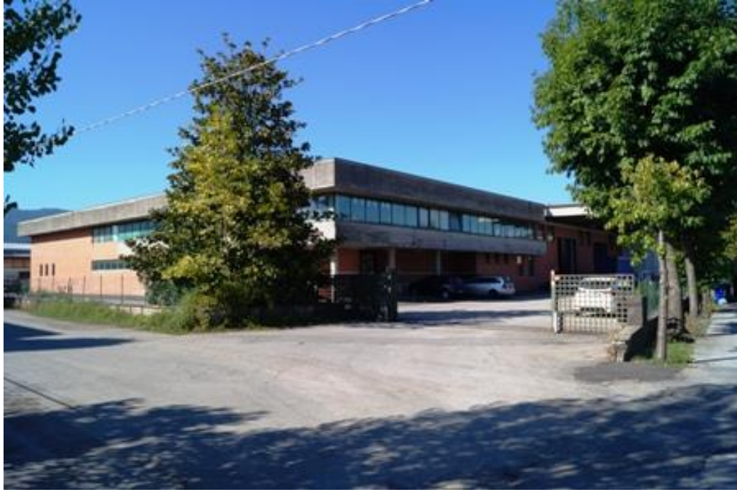
FOTO 1 ESTERNO - Fabbricato n. 1
