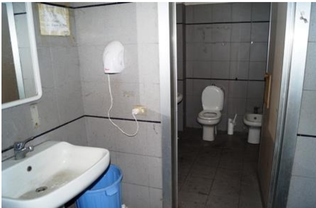
FOTO 10 SERVIZI IGIENICI P.T. – Fabbricato 1
