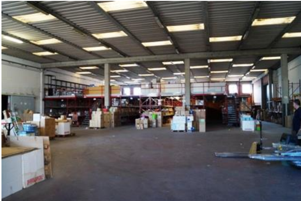
FOTO 5 INTERNO P.T. h. 6,50 – Fabbricato 1
