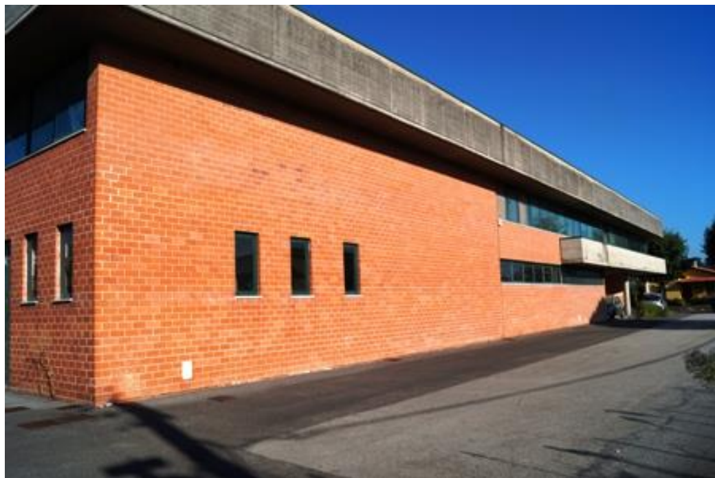
FOTO 2 ESTERNO- Fabbricato n. 1
