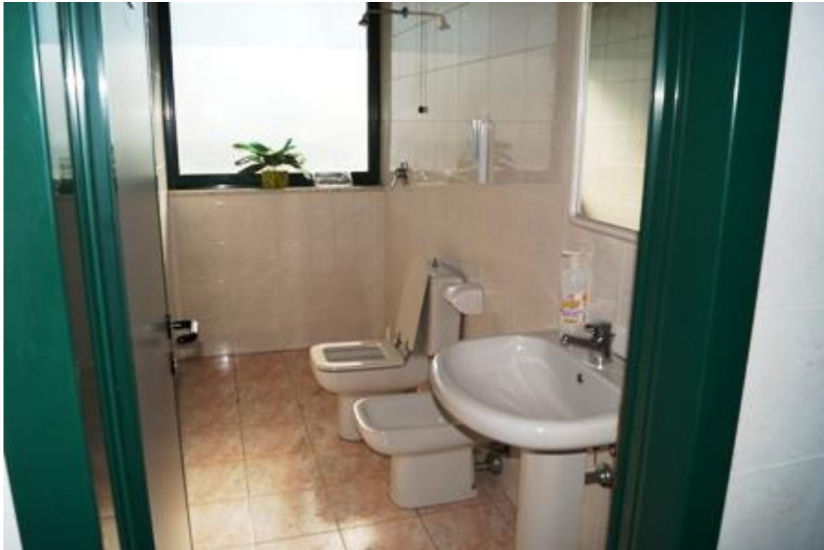
FOTO 15 SERVIZI IGIENICI P.1° -Fabbricato 1
