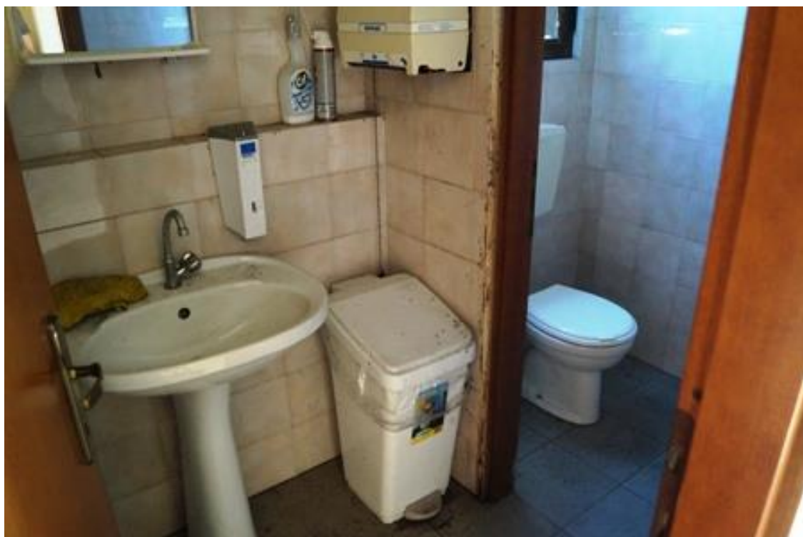
FOTO 23 SERVIZIO IGIENICO P.T. - Fabbricato 3
