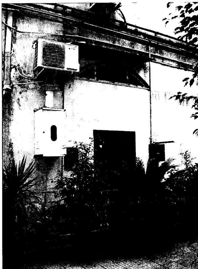
FOTO N. 18 – finestra porzione di unità i. 2 che affaccia sul cortile
