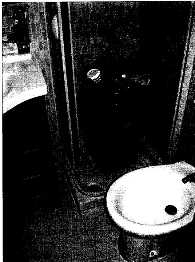
FOTO N. 23 – porzione d'unità i. 2: bagno
