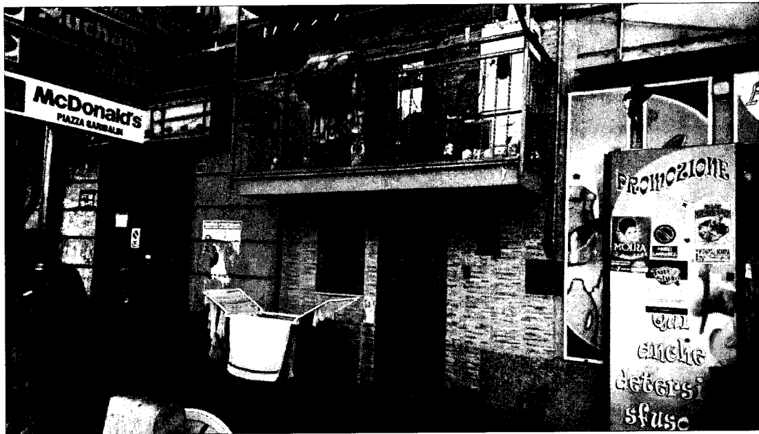
FOTO N. 3 – Porzione unità i. 1: Accesso da via Arenaccia, 183
