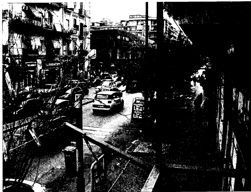
FOTO N. 14 – Porzione unità i. 1: balcone con affaccio su via Arenaccia
