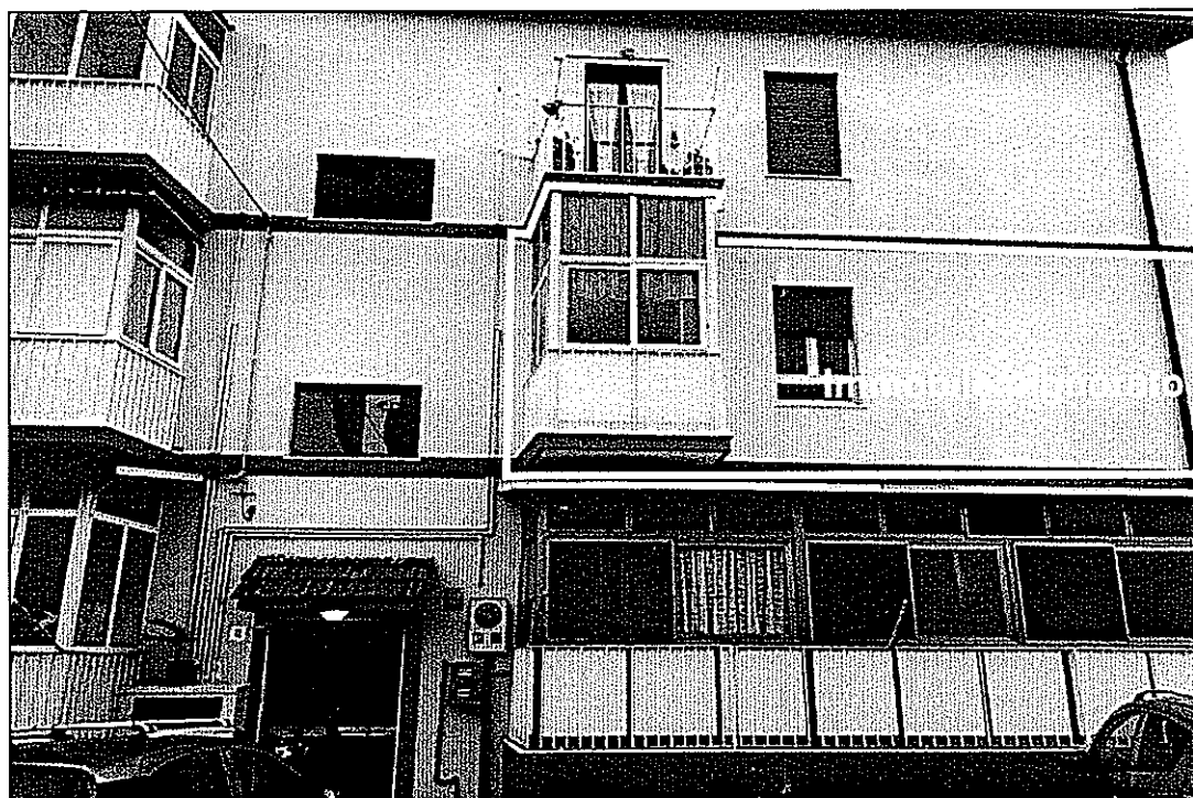
Foto n.4 - Prospetto nord su area interna di proseguo della via Cadorna
