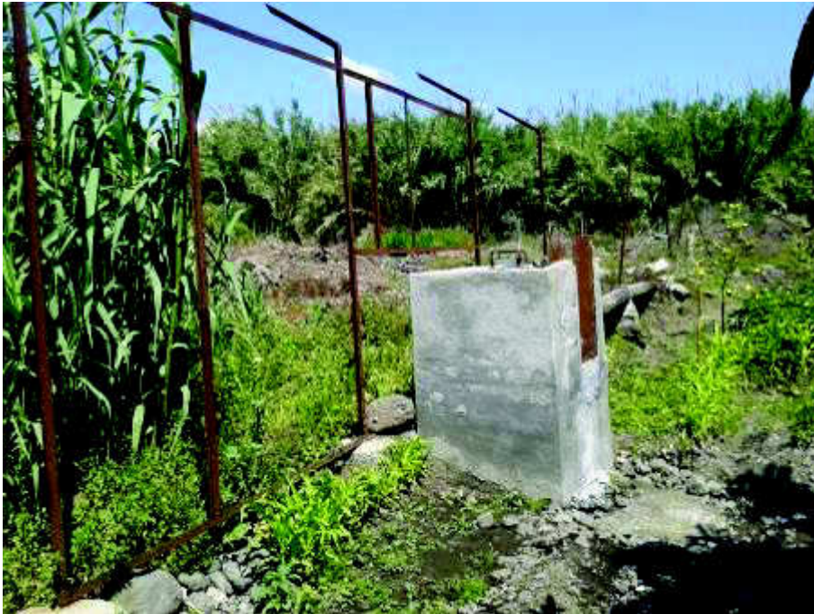
Foto n°15: Vista del pozzo con tubazione in cemento
