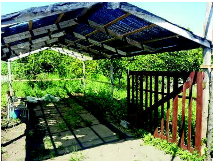
Foto n°8: Vista della tettoia in legno d'ingresso al terreno
