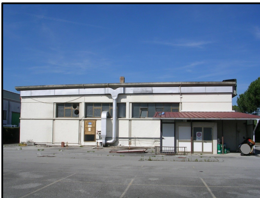
(prospetto sud-ovest fabbricato principale)
