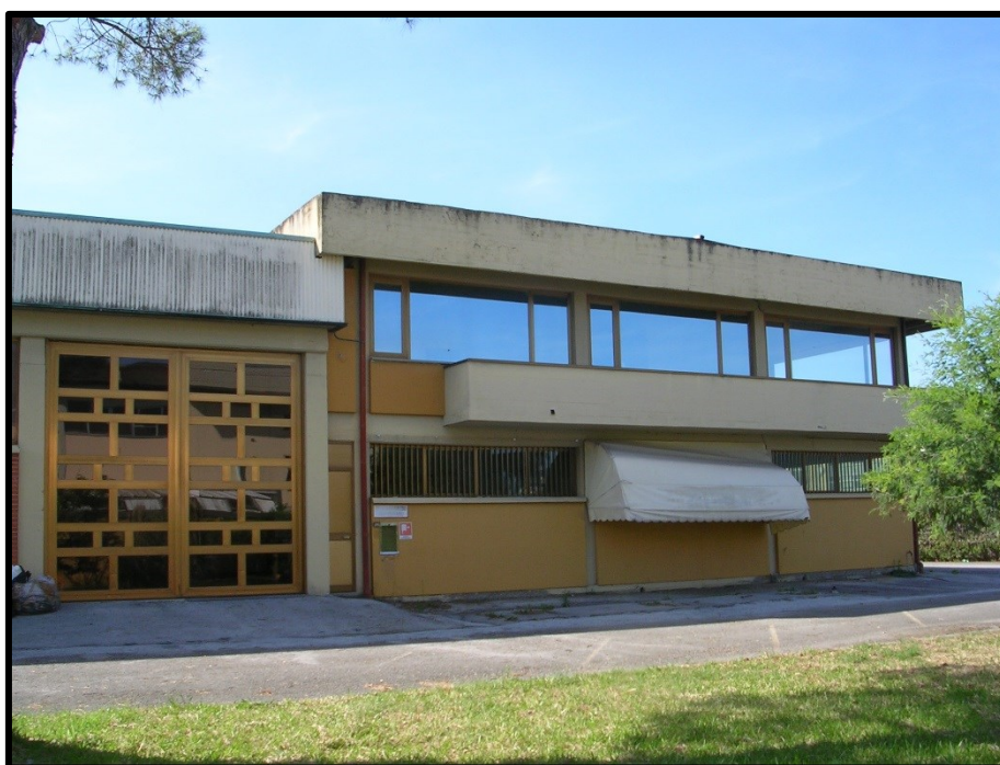
(particolare prospetto sud fabbricato principale)
