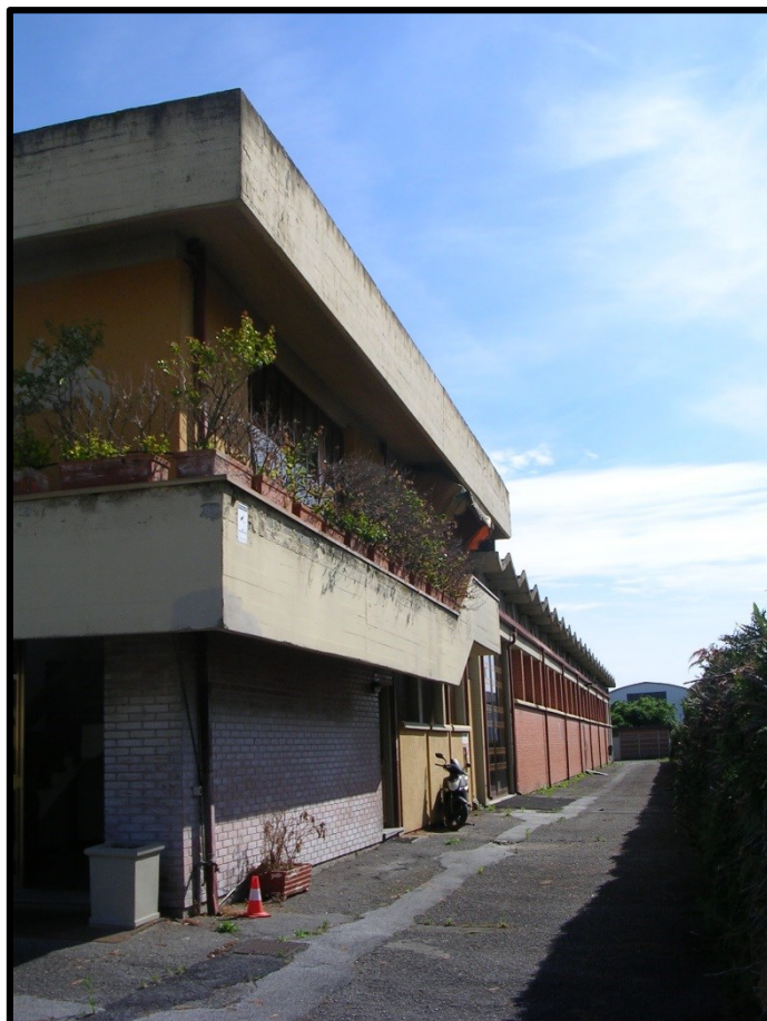
(prospetto nord fabbricato principale)
