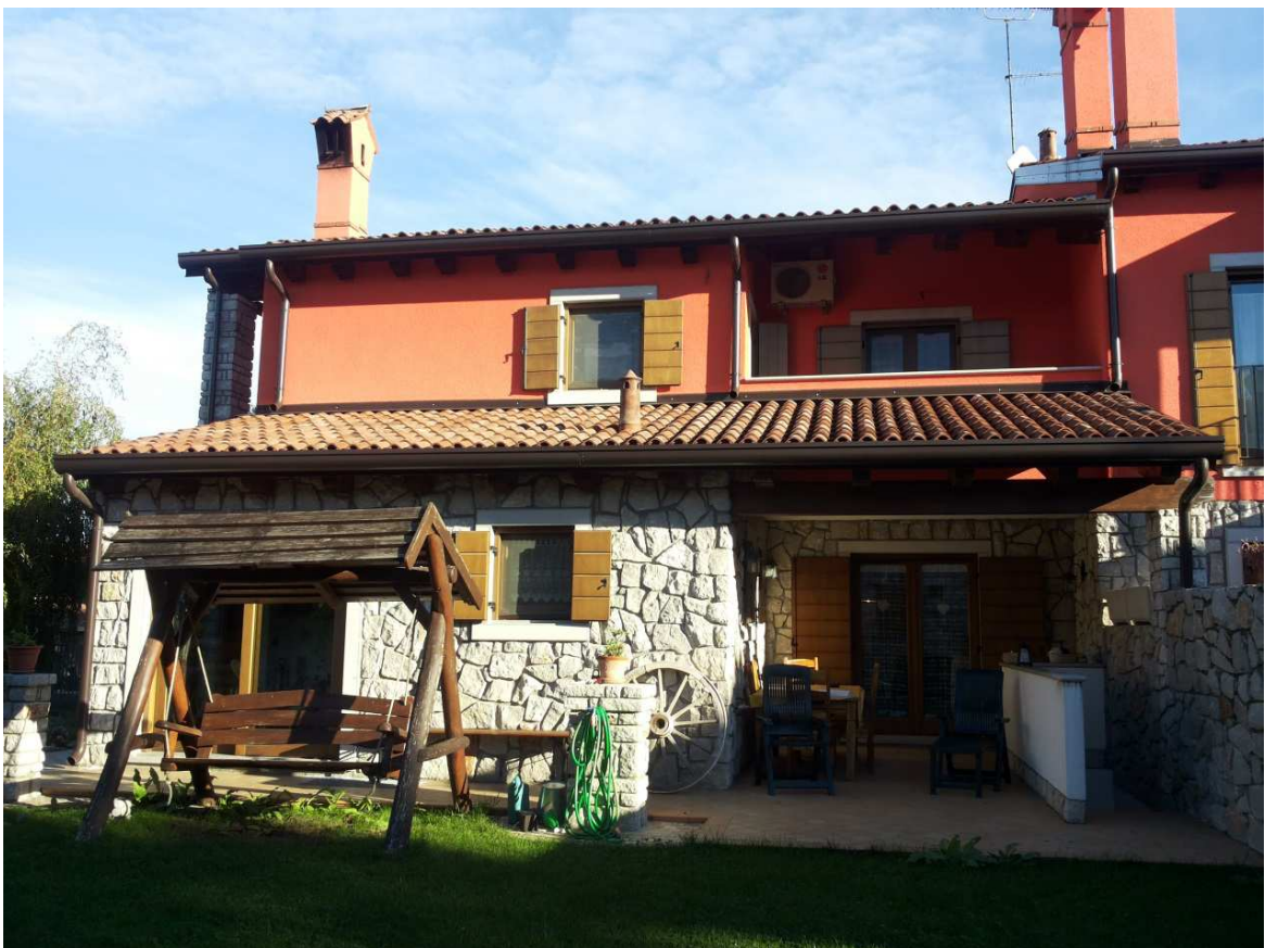
FOTO n. 4- P.T. 5017 - p.c.n. 409/7 - Edificio unifamiliare - Facciata sud vista dal giardino
