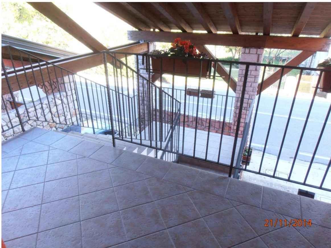
FOTO n. 20 – Scala condominiale di accesso all'alloggio sito al primo piano P.T. 5162
