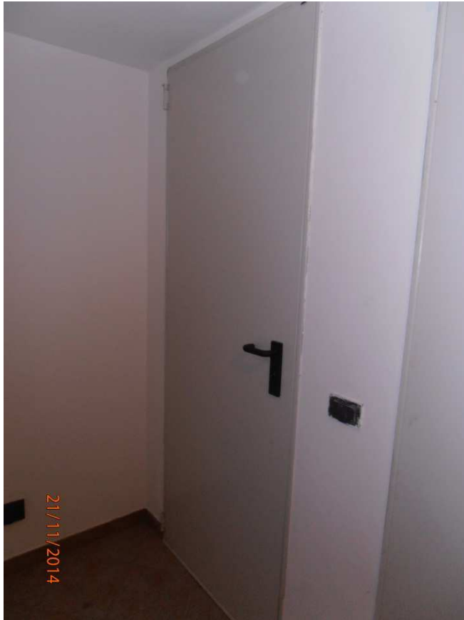
FOTO n. 39 – Porte ingresso cantine
