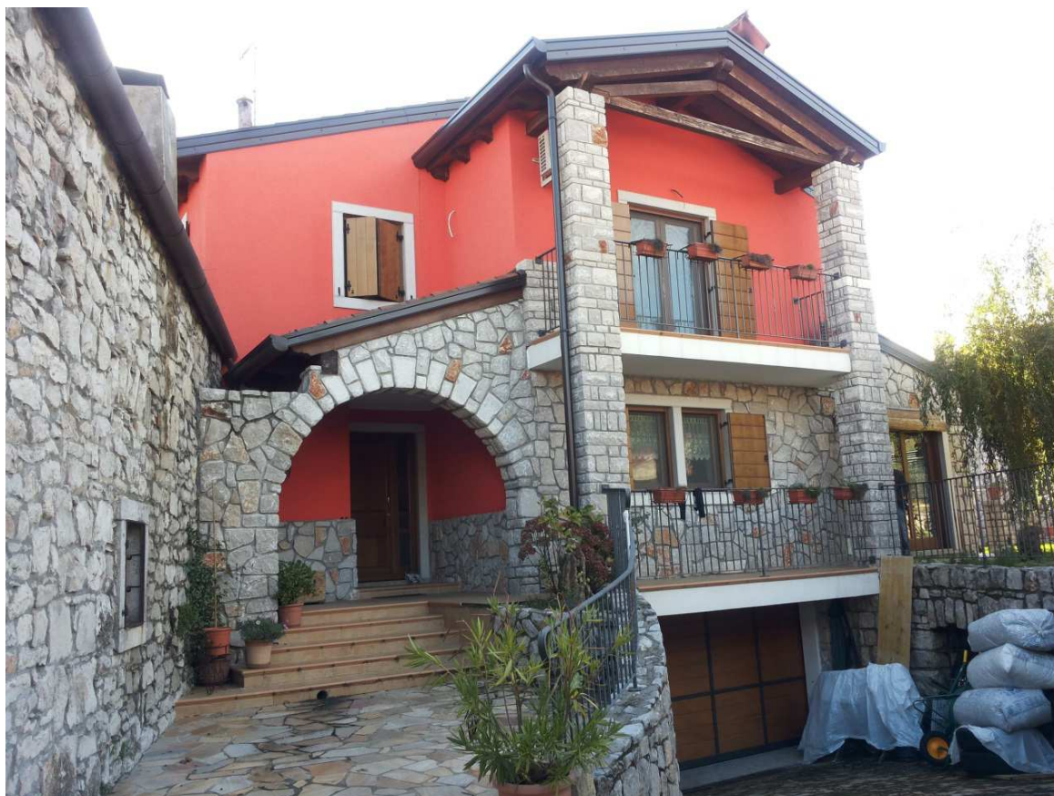
FOTO n. 2 - P.T. 5017 - p.c.n. 409/7 - Edificio unifamiliare - Facciata ovest
