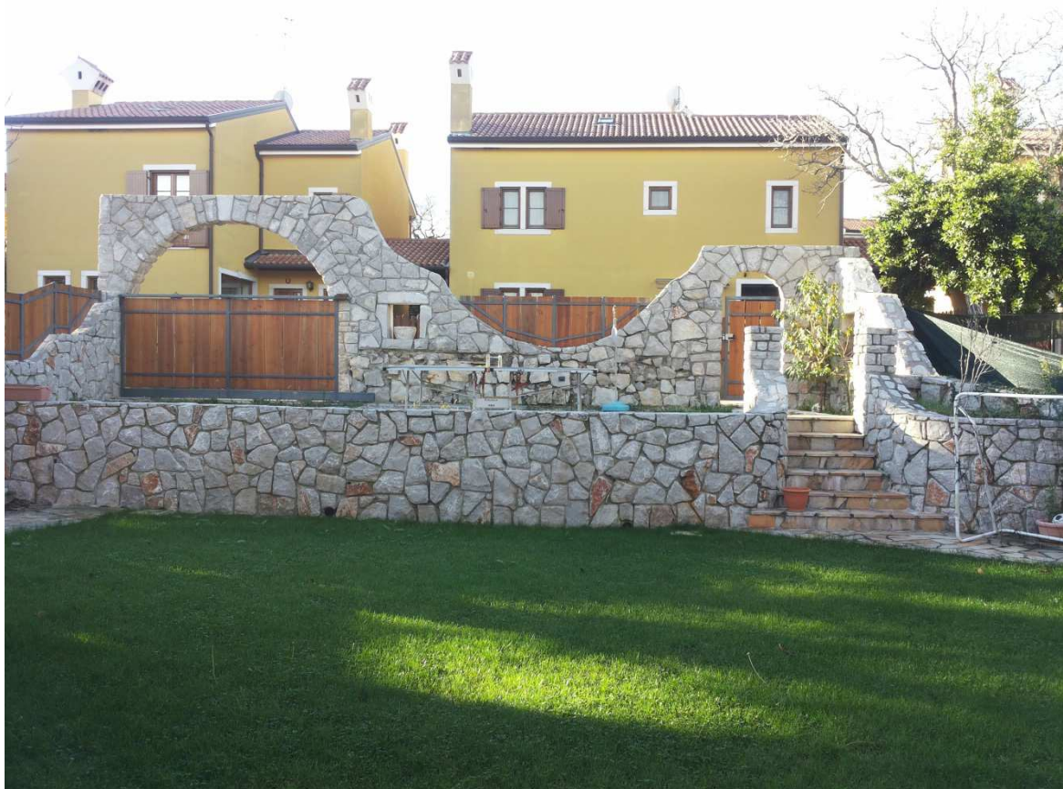
FOTO n. 6 - P.T. 5017 - p.c.n. 409/7 - Edificio unifamiliare - Giardino
