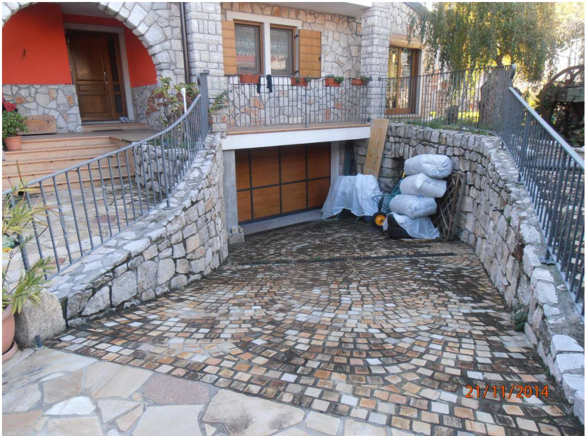
FOTO n. 3 - P.T. 5017 - p.c.n. 409/7 - Edificio unifamiliare – Rampa di accesso al garage
