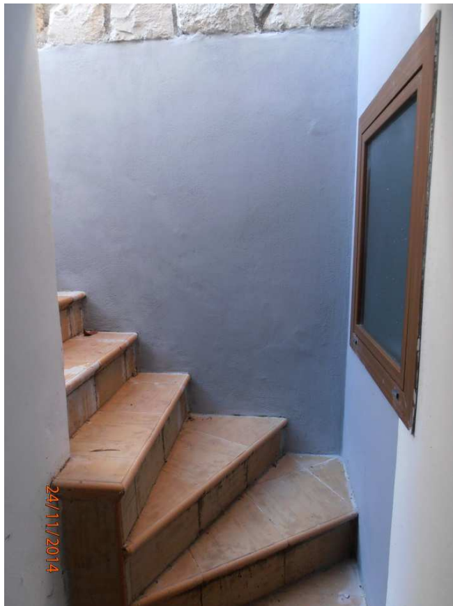
FOTO n. 36 – P.T. 5160 - p.c.n. 409/8 sub 13 – Scala esterna di accesso al piano interrato
