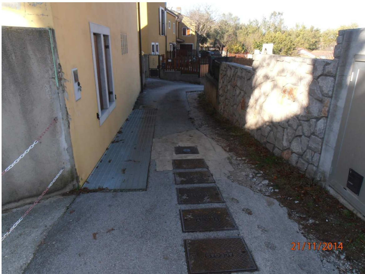
FOTO n. 28 – Porzione di strada interna corrispondente alle PP.TT. 810-5011-5084
