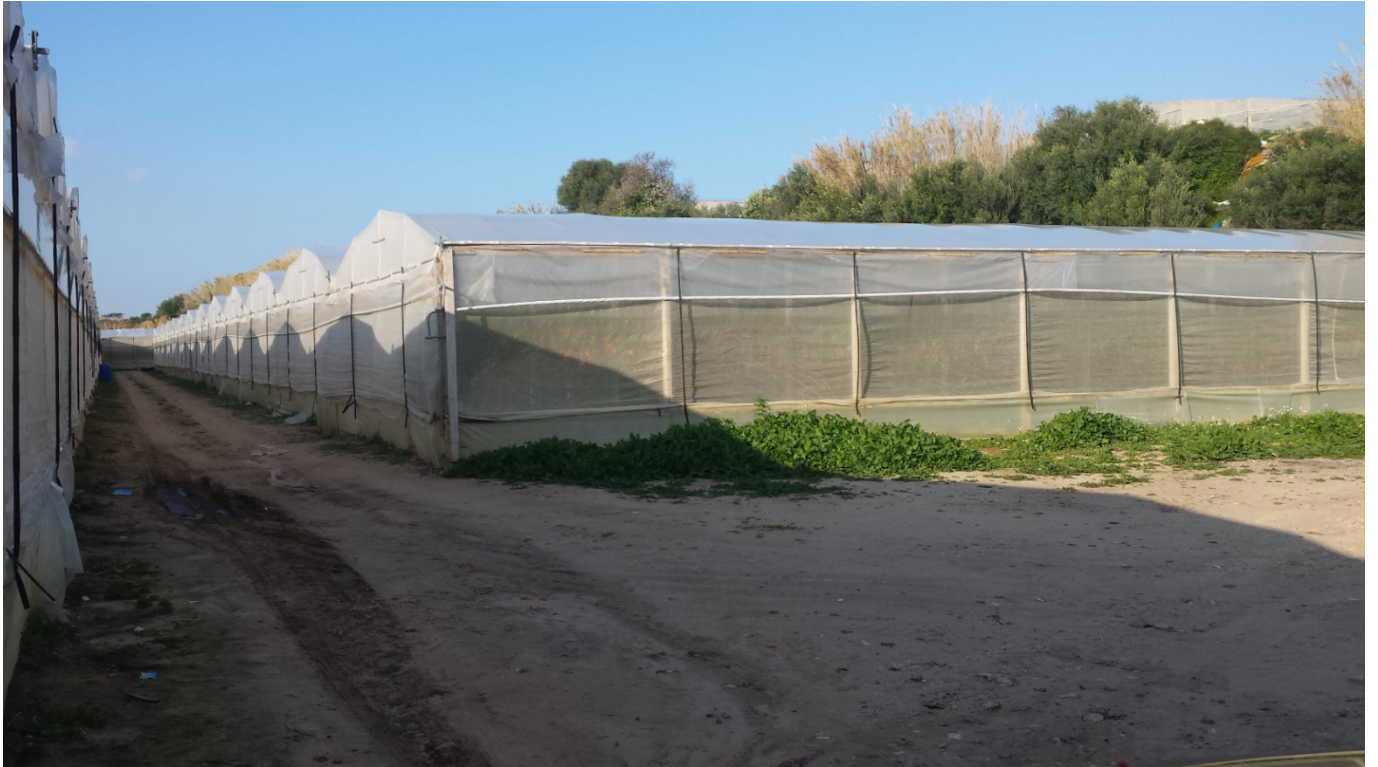
Foto n.3 - Zona a Serre
