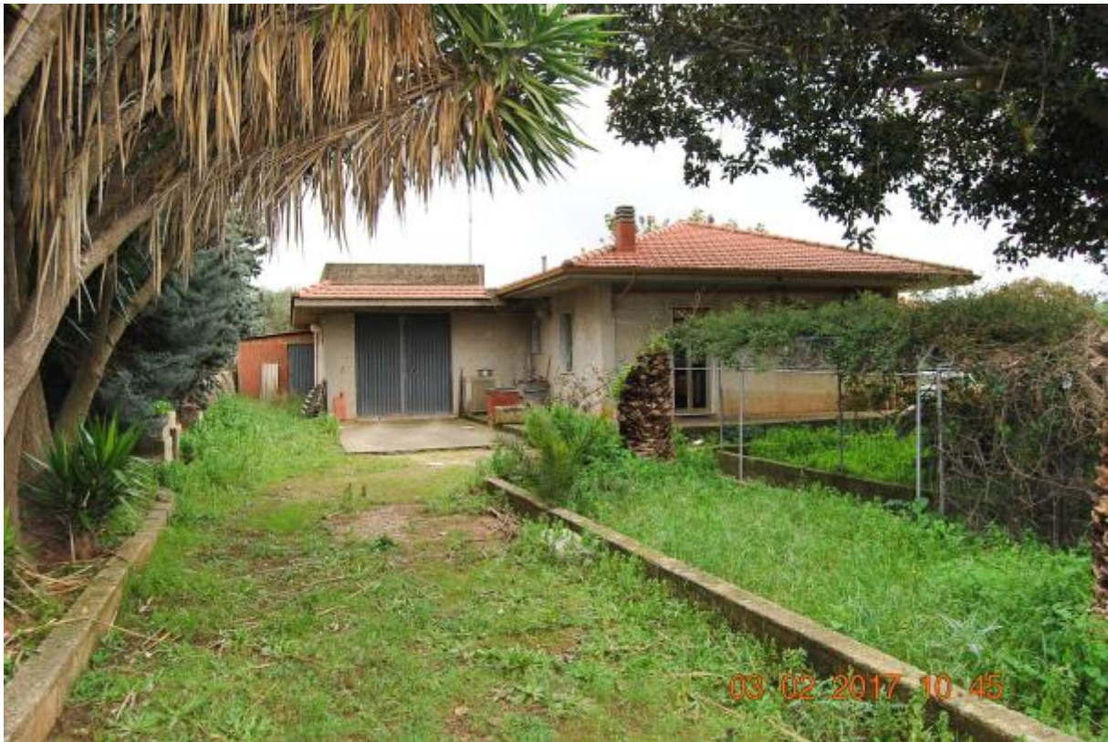
Foto 7 - La villetta vista dall'ingresso secondario
