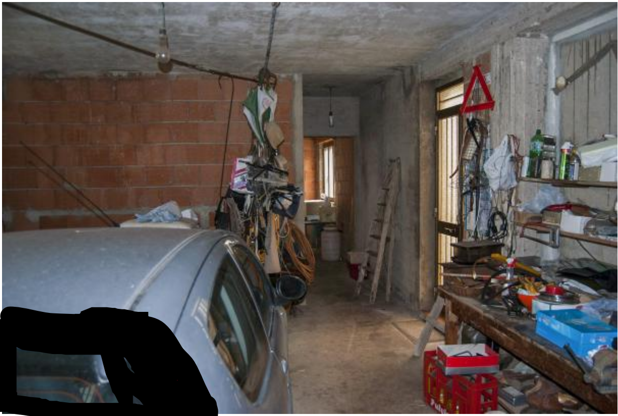
Foto 23 - Vista di parte del garagei
