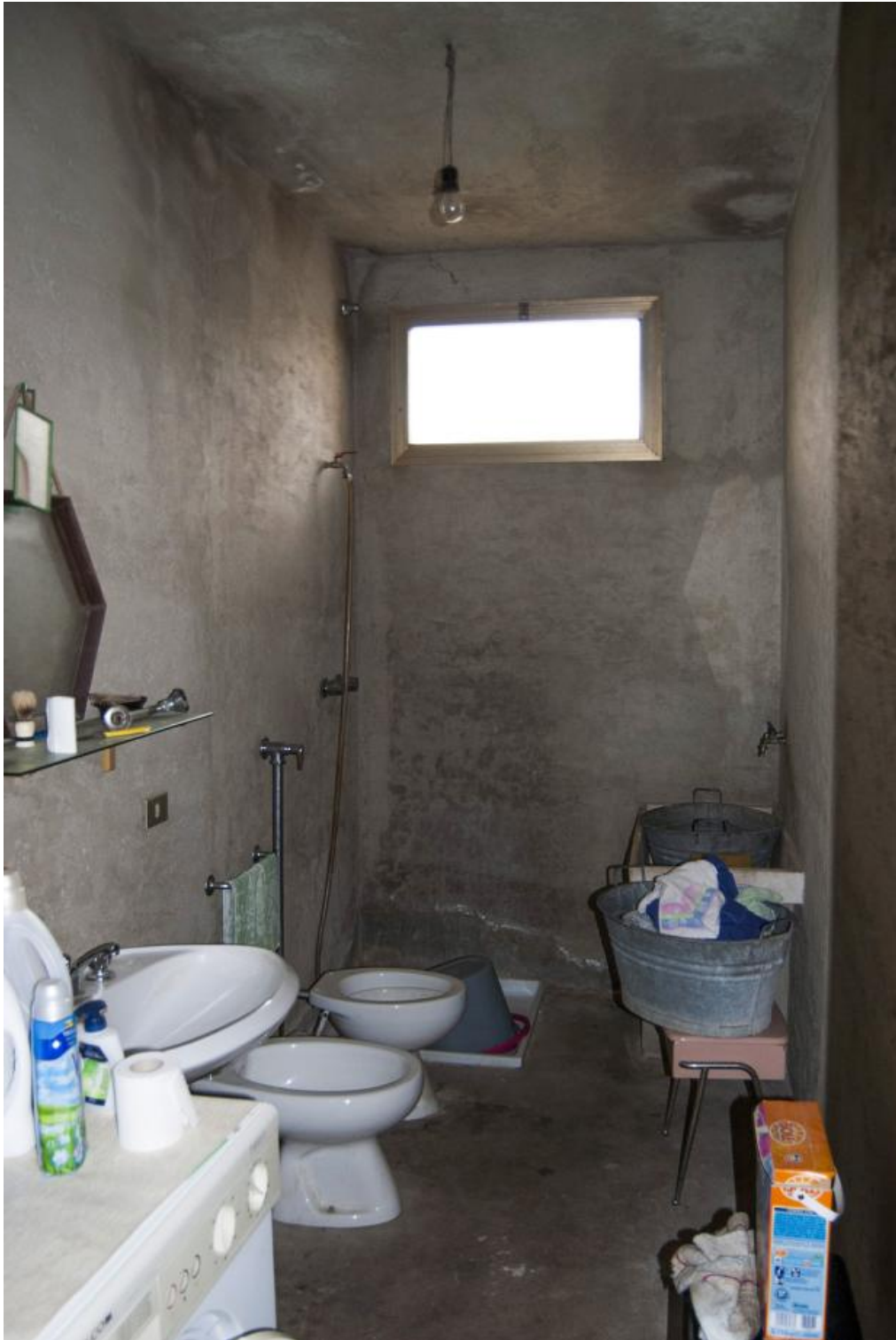
Foto 25 - Il w.c. a servizio del garage
