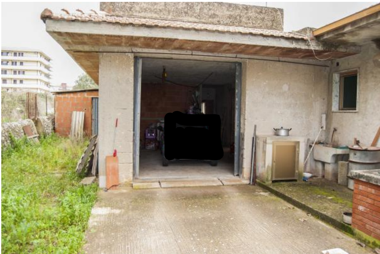
Foto 8 - Particolare dell'ingresso al garage
