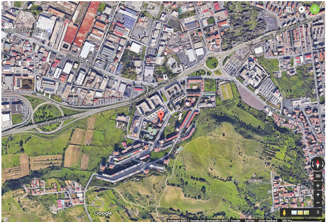
FO-01 Veduta aerea
