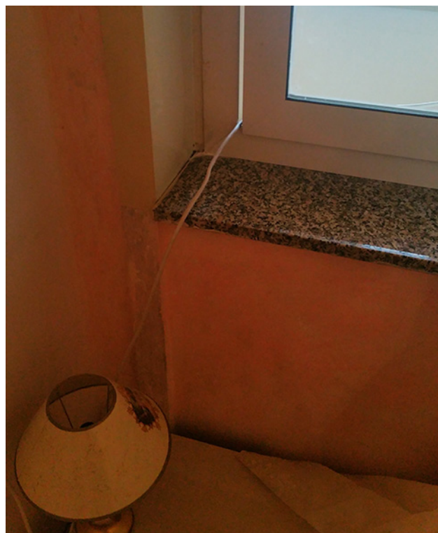
FO-32 Portafinestra trasformata in finestra
