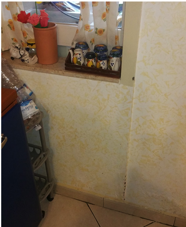
FO-29 Portafinestra trasformata in finestra
