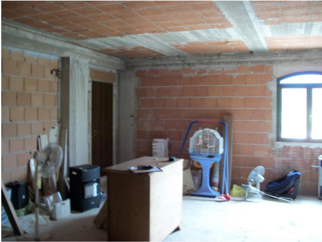
FOTO n. 7 – INTERNO LOCALE RUSTICO - PIANO TERRA
