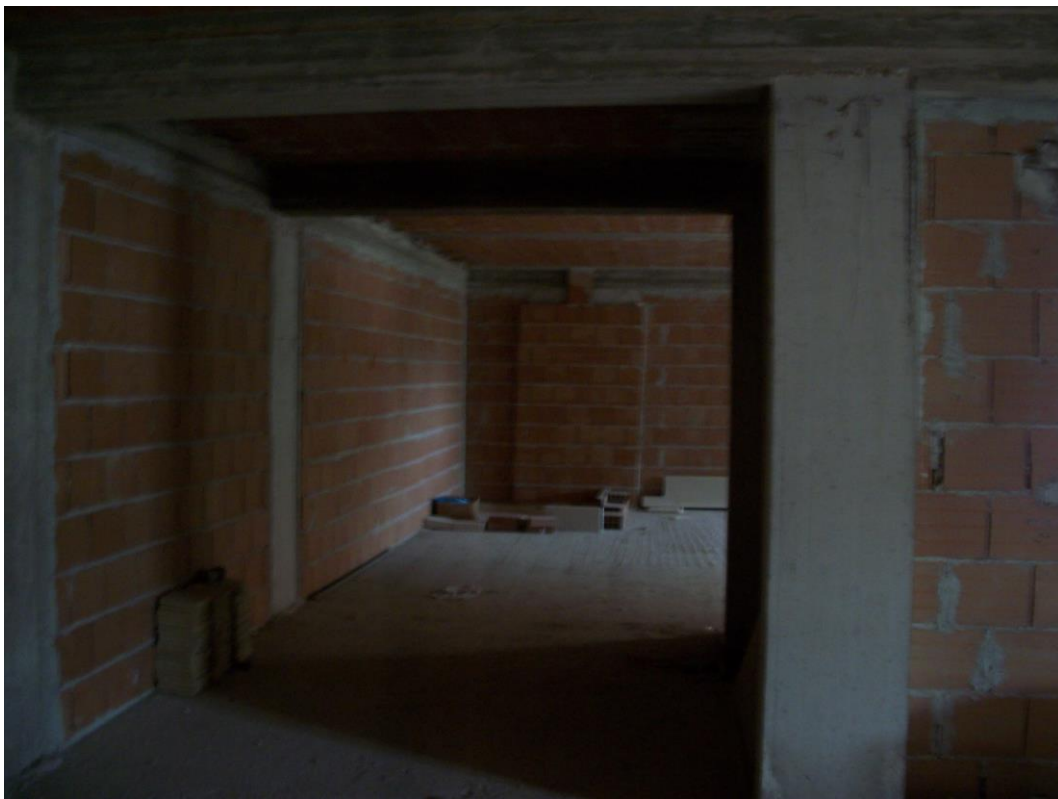
FOTO n. 8 – INTERNO LOCALE RUSTICO - PIANO TERRA
