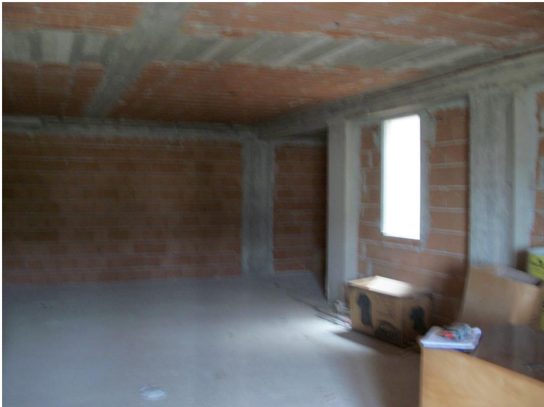
FOTO n. 4-INTERNO LOCALE RUSTICO - PIANO TERRA
