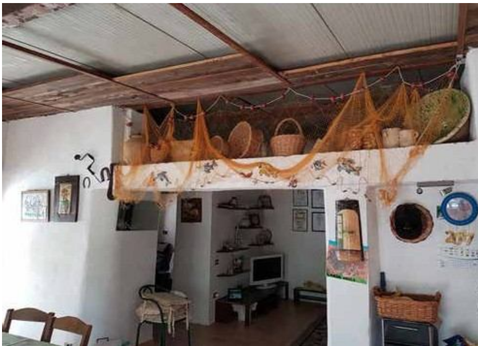
Foto 40. Dependancy di cui si prevede la demolizione.
