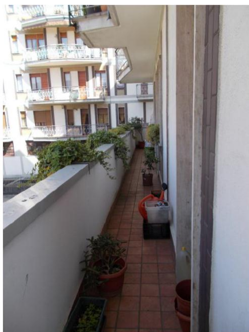
39. Balcone lato nord
