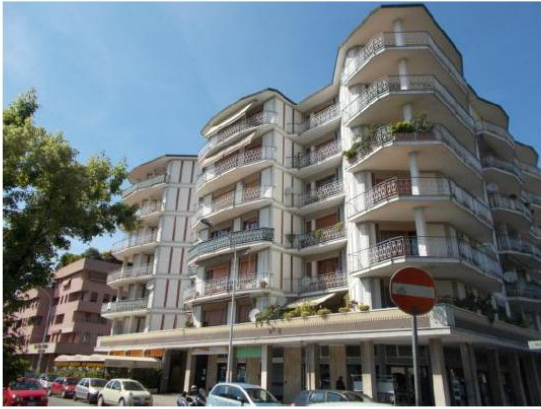
1. Panoramica del condominio
