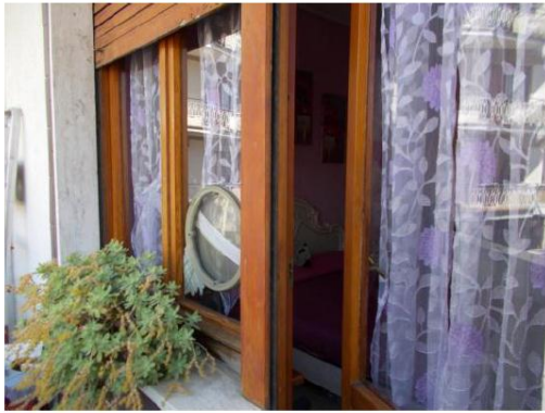
41. Particolare di un serramento esterno
