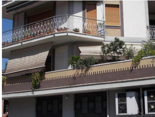
4. Particolare del terrazzo
