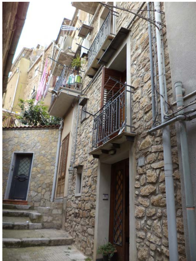
Foto n.11 – Ingresso da Cortile Torina
