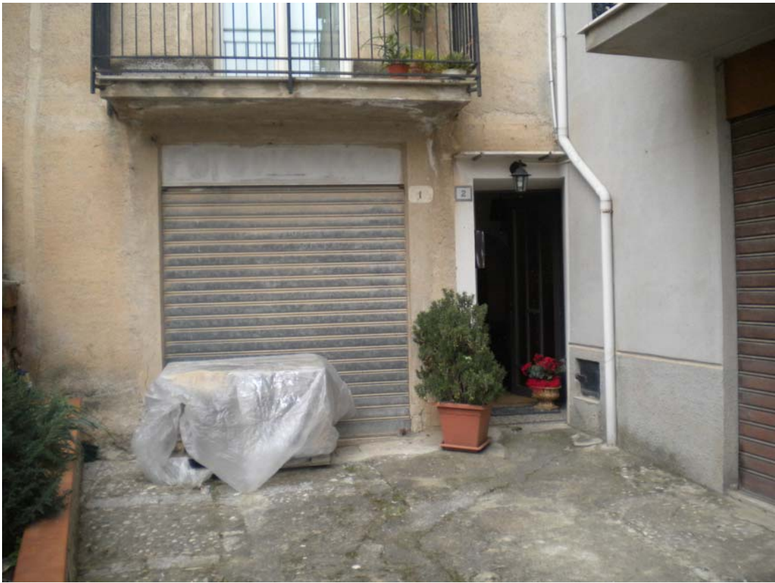
Foto n. 3 – Ingresso esterno da Piazza S. Elia
