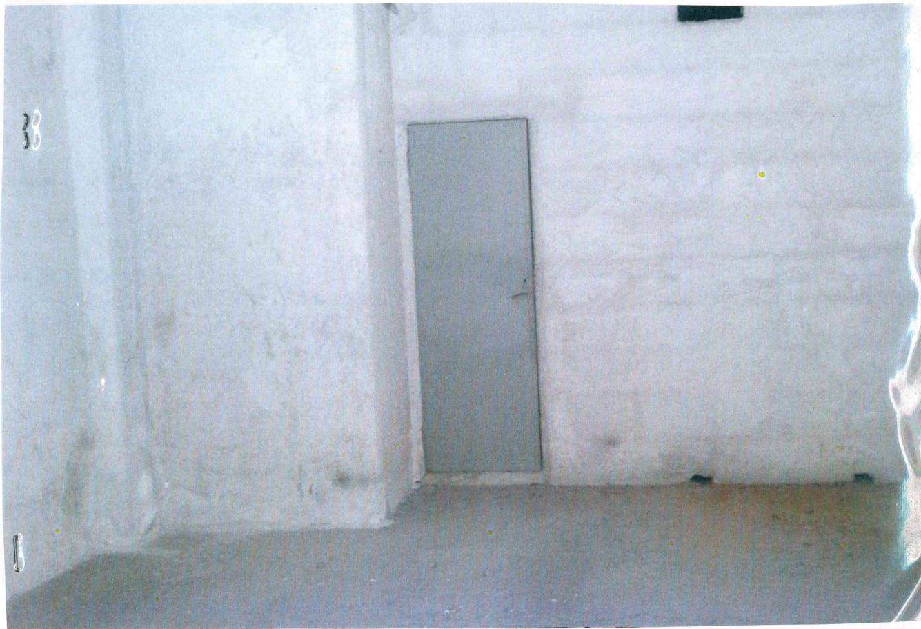
INTERNO GARAGE VIA PO' N. 19
