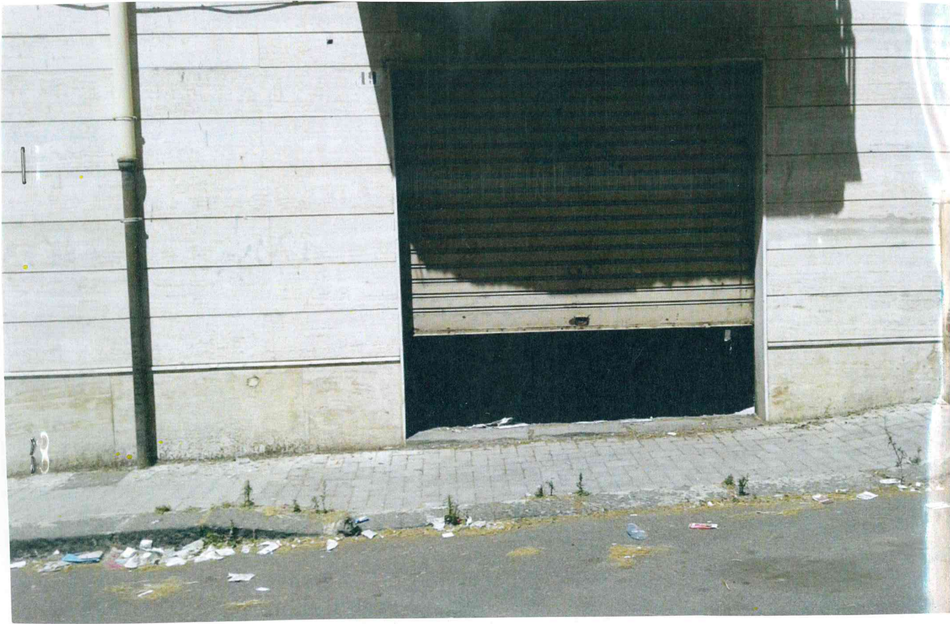
GARAGE - VIA PO' N. 19 - FG FU - PART. 630 - SUB 4
