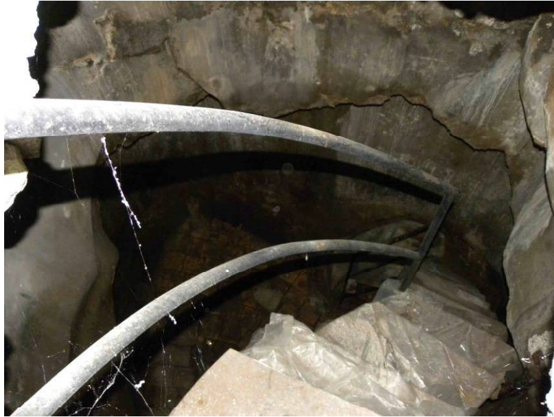
Foto 16 – Vista scala accesso alla cisterna dal vano 4
