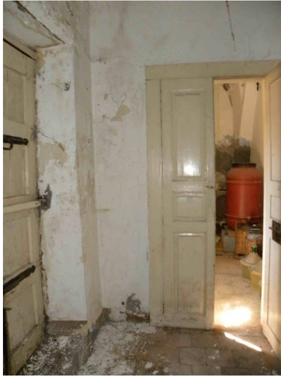
Foto 11 – vista disimpegno (vano 5)
