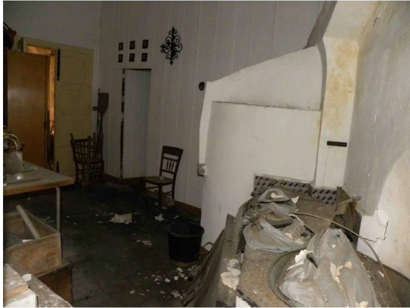
Foto 8 – vista vano centrale (porzione a sud identificata con il n.4)
