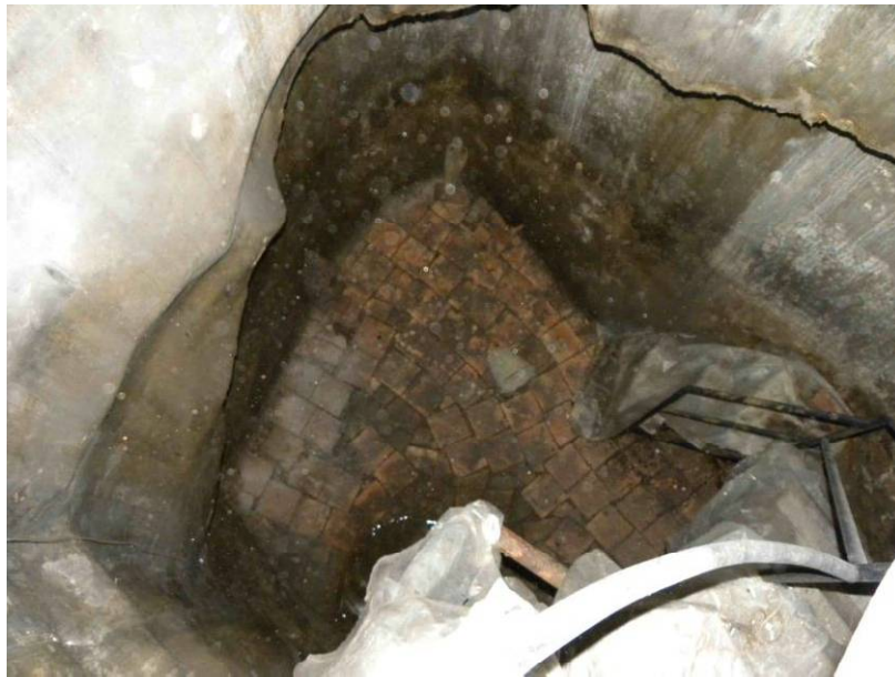
Foto 17 – Vista interno della cisterna
