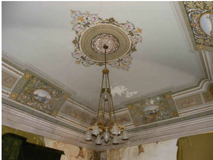
Foto 7 – Dettaglio volta vano 2
