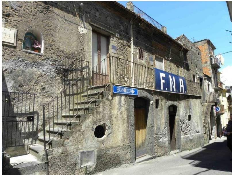
Foto 1 – Vista esterno fabbricato da via G. D'Annunzio
