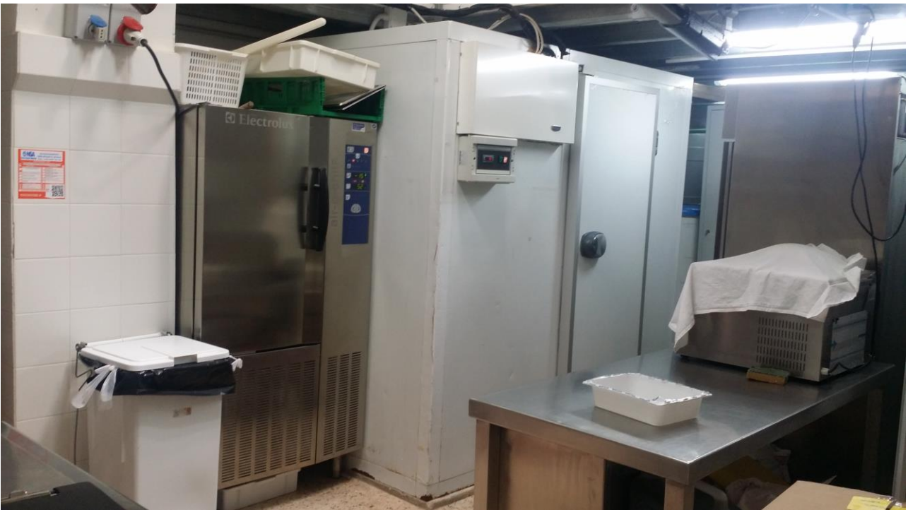
Foto 03. Interno del deposito
