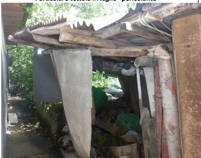
Particolare tettoia in legno "pericolante"
