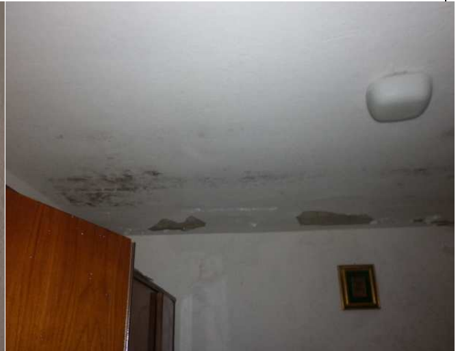
Particolare 2 – Umidità nella camera
