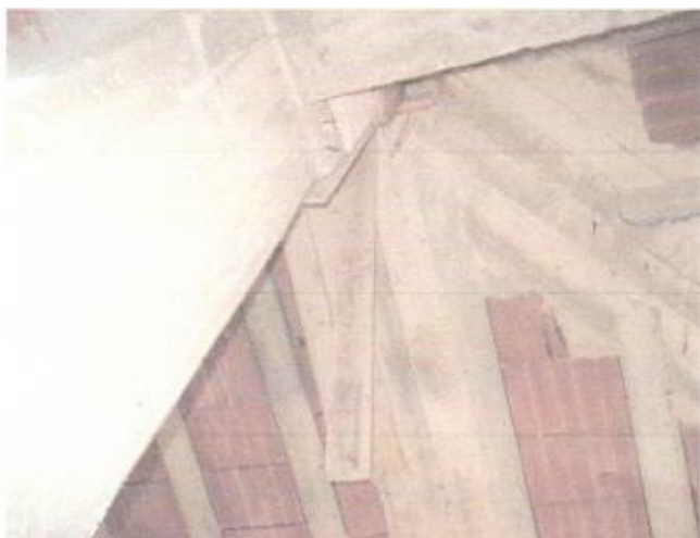
Foto 5 veduta del tetto dall'interno
