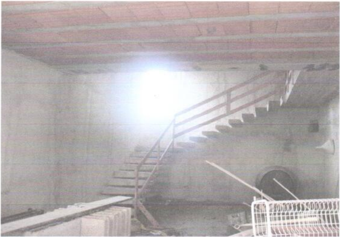
Foto 3 vano ingresso con scala
