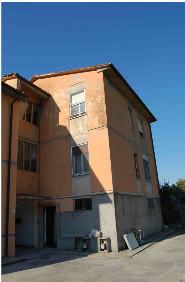
Lato nord est
