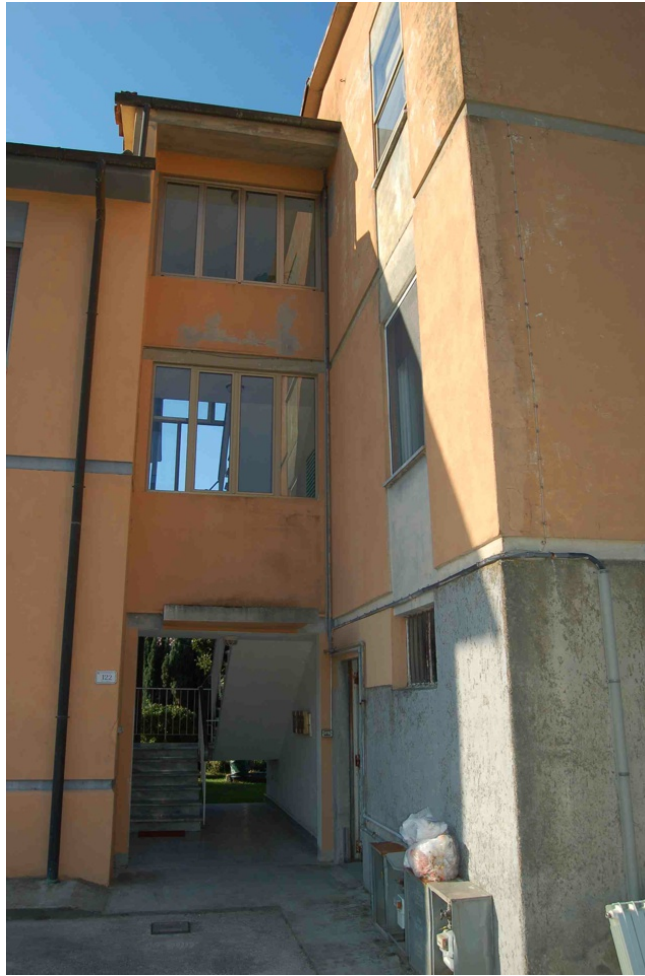
Ingresso e scala condominiale
