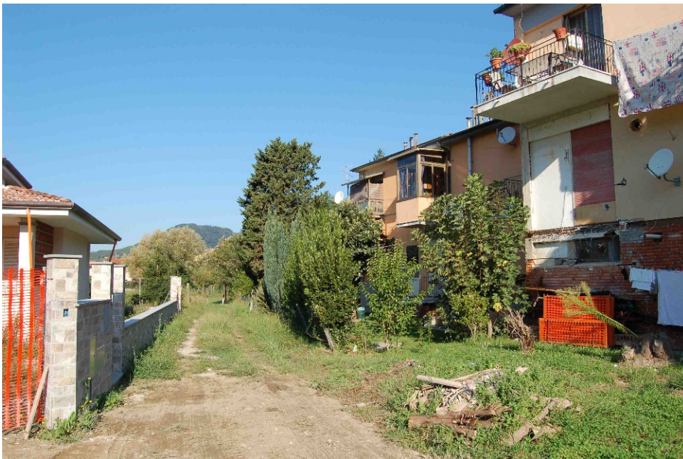
Condominio lato sud
