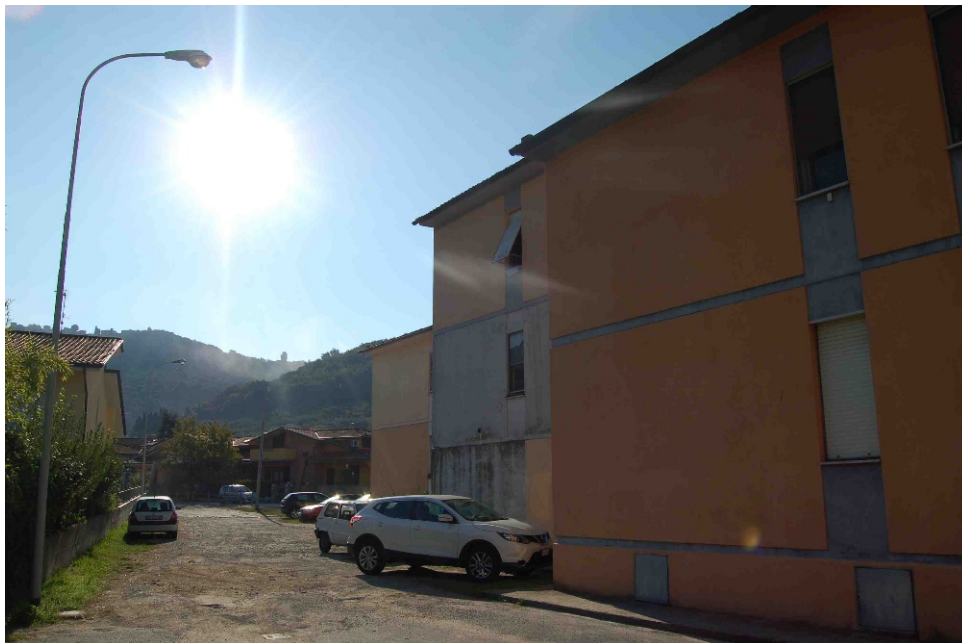
Lato nord e resede condominiale
