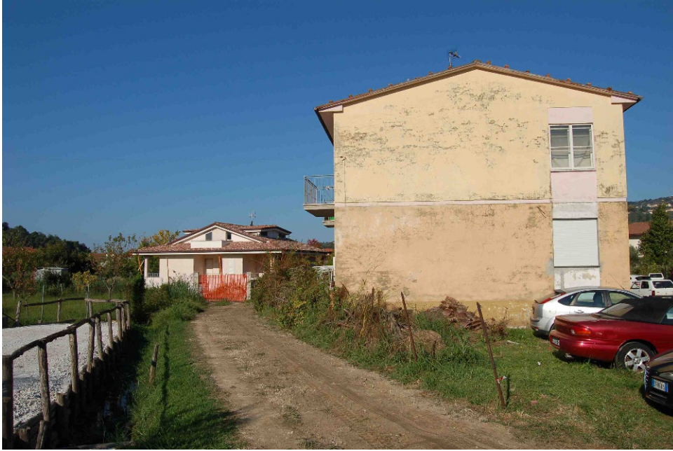
Condominio lato sud est
