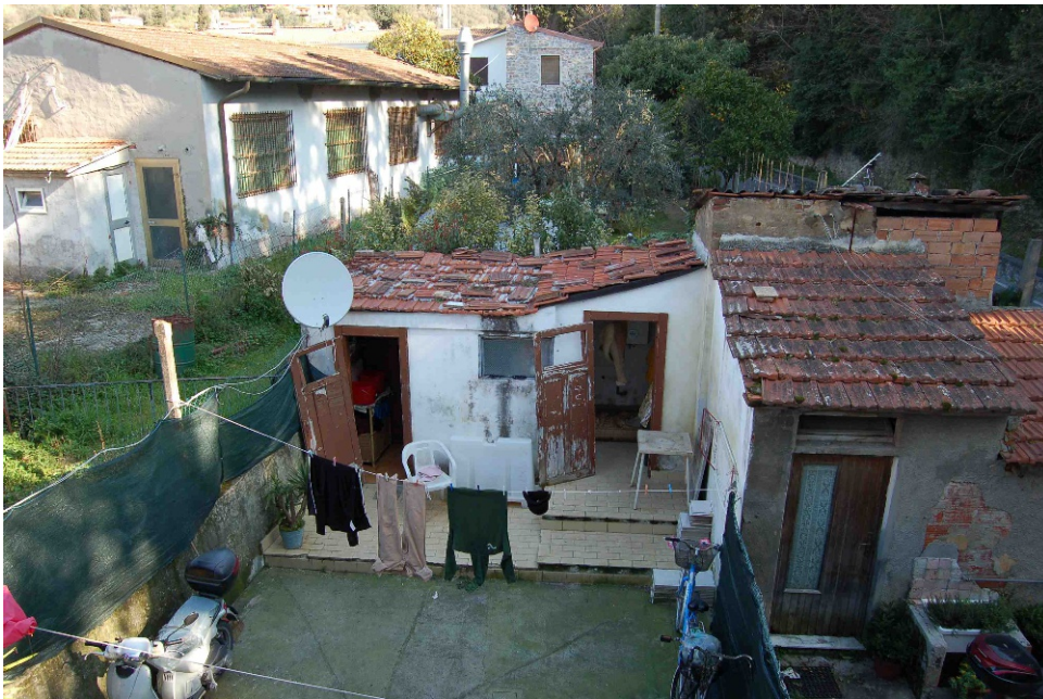
Resede e ripostigli sul lato nord
