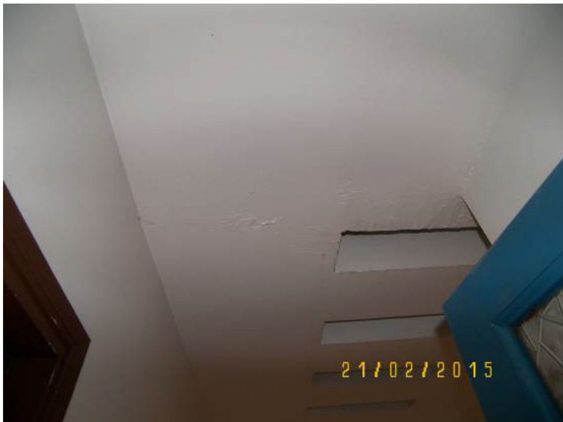
Foto n. 25 – Copertura vano scala
