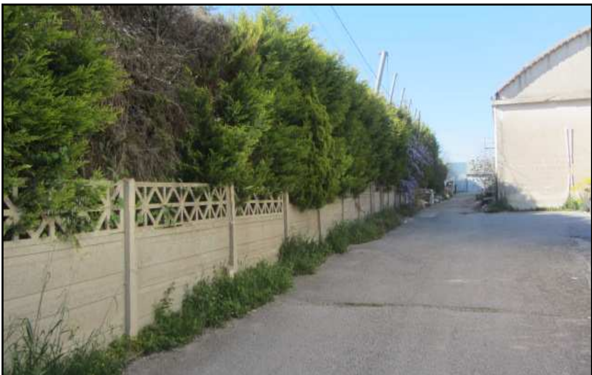
Foto b: muro di recinzione del lotto.
