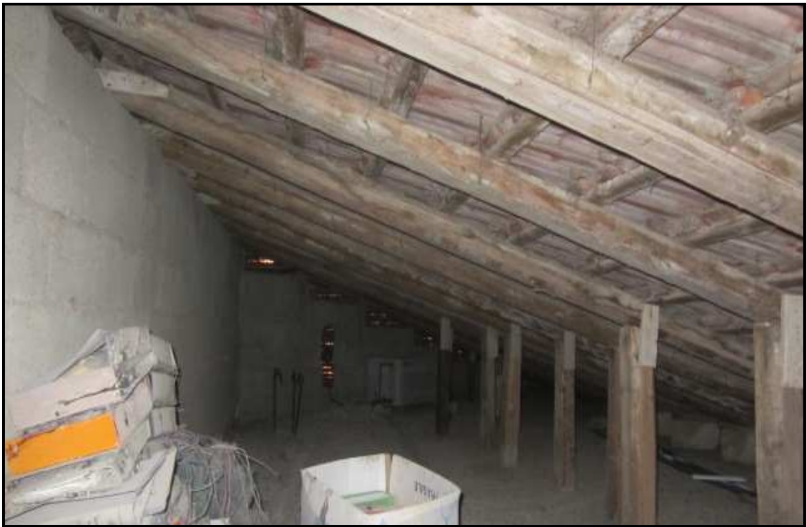
Foto q: sottotetto cespite N°2.
