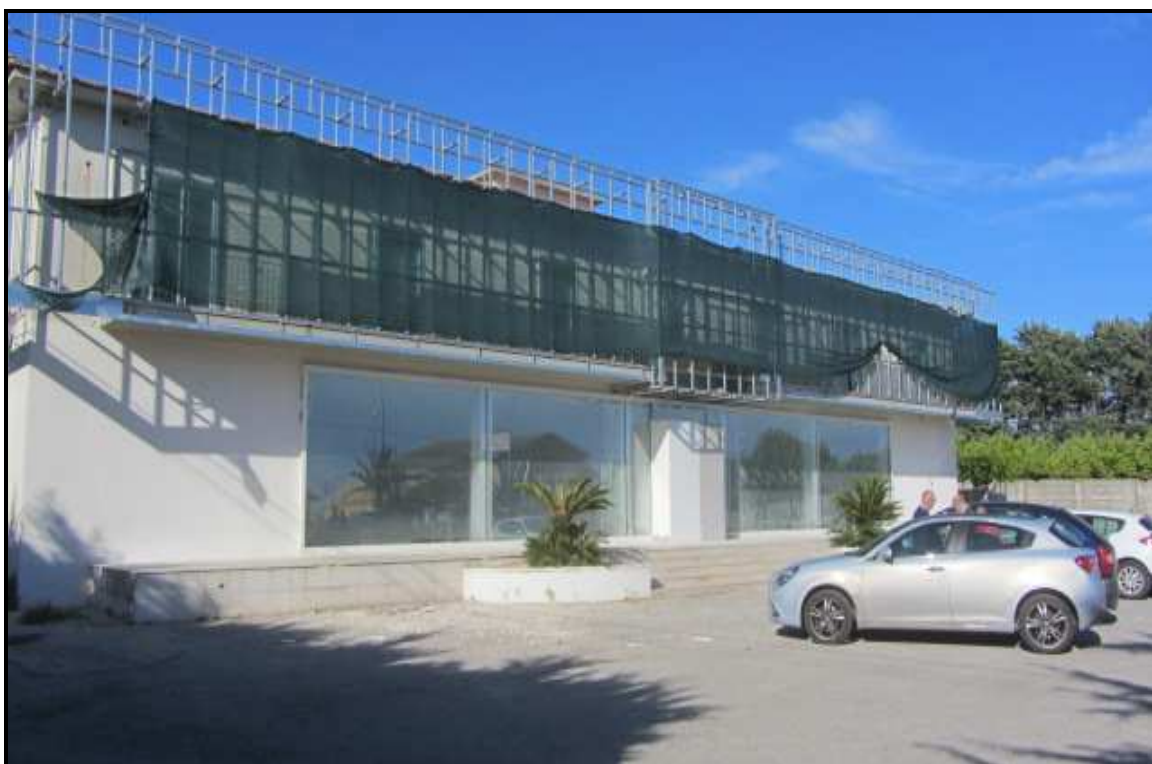
Foto f: prospetto cespite N°2 lato sud.
