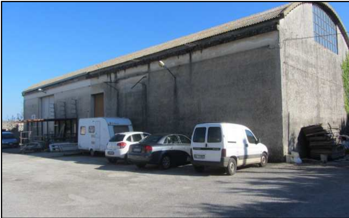
Foto c: prospetto cespite N°4 lato nord.
