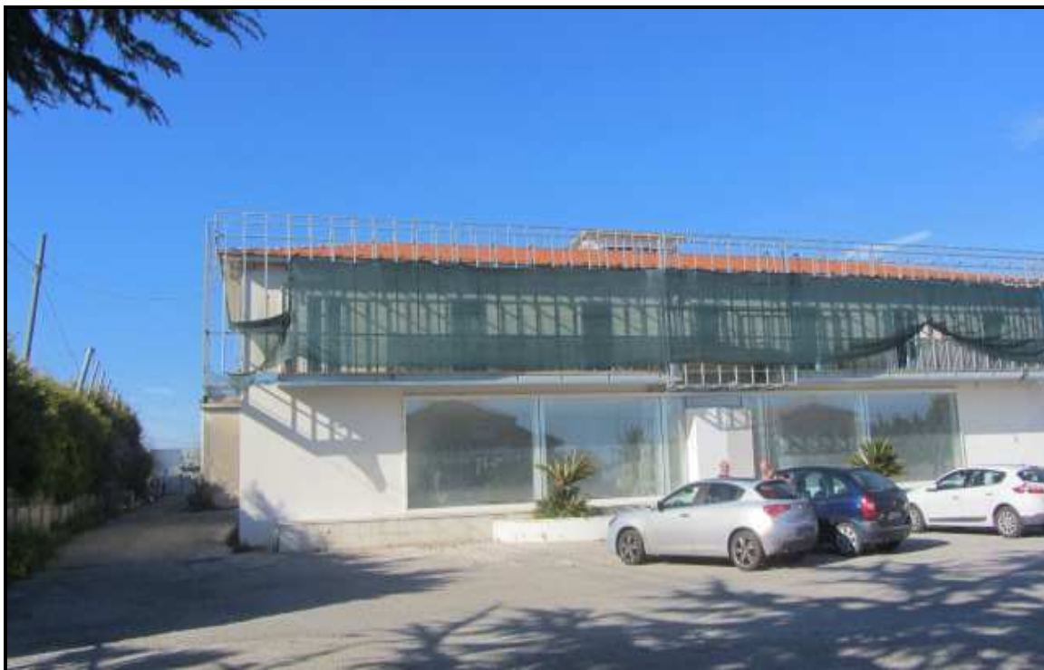
Foto e: prospetto cespite N°2 lato sud.
