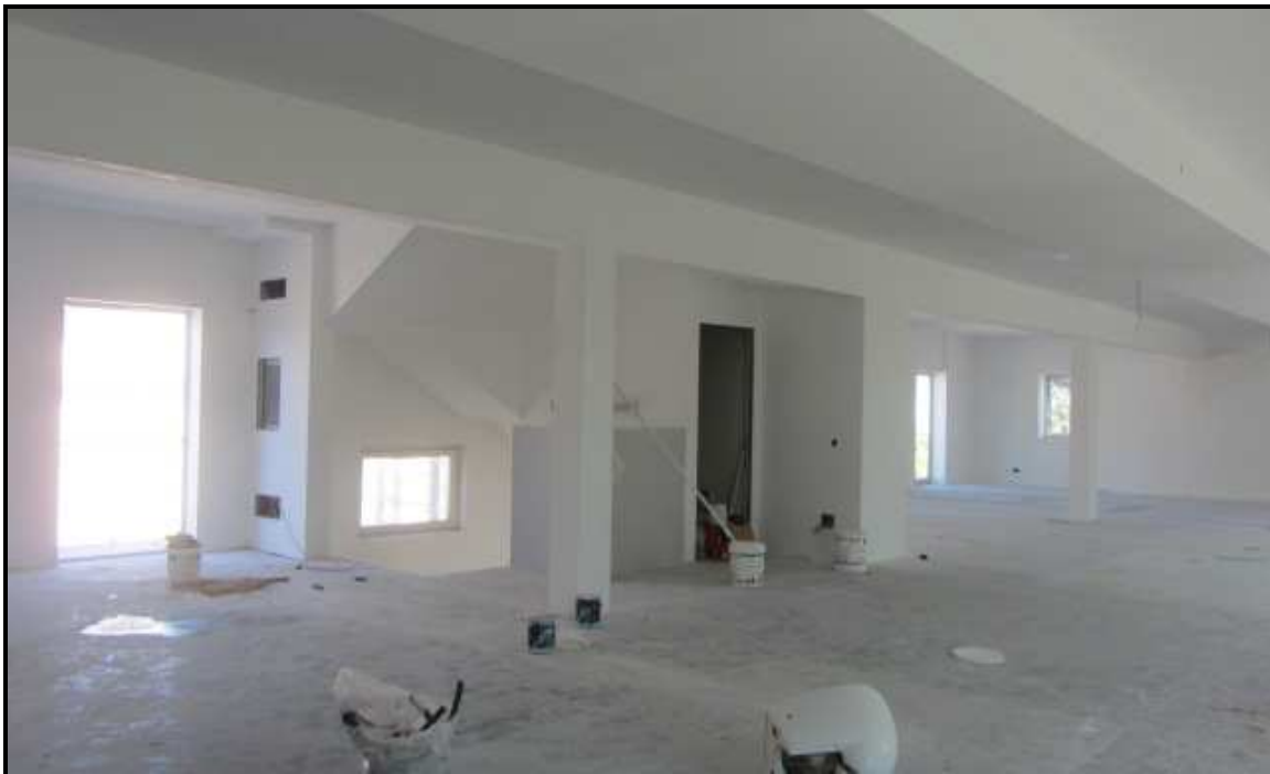
Foto i: interno P.1° cespite N°2 lato sud-est.
