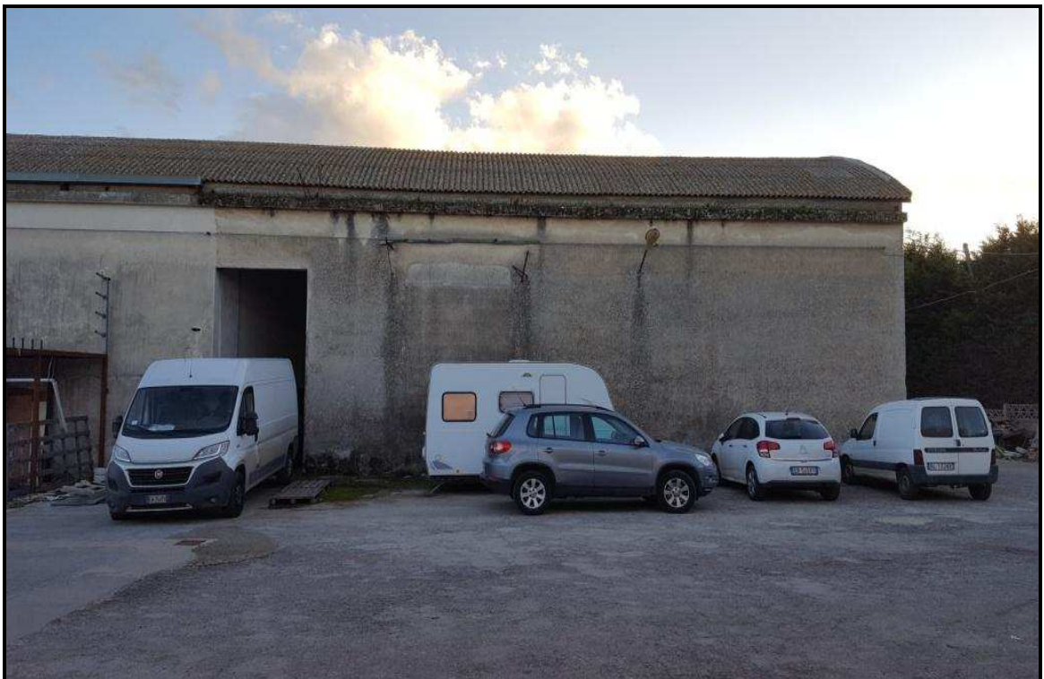
Foto x: prospetto del cespite N°4 lato nord.
