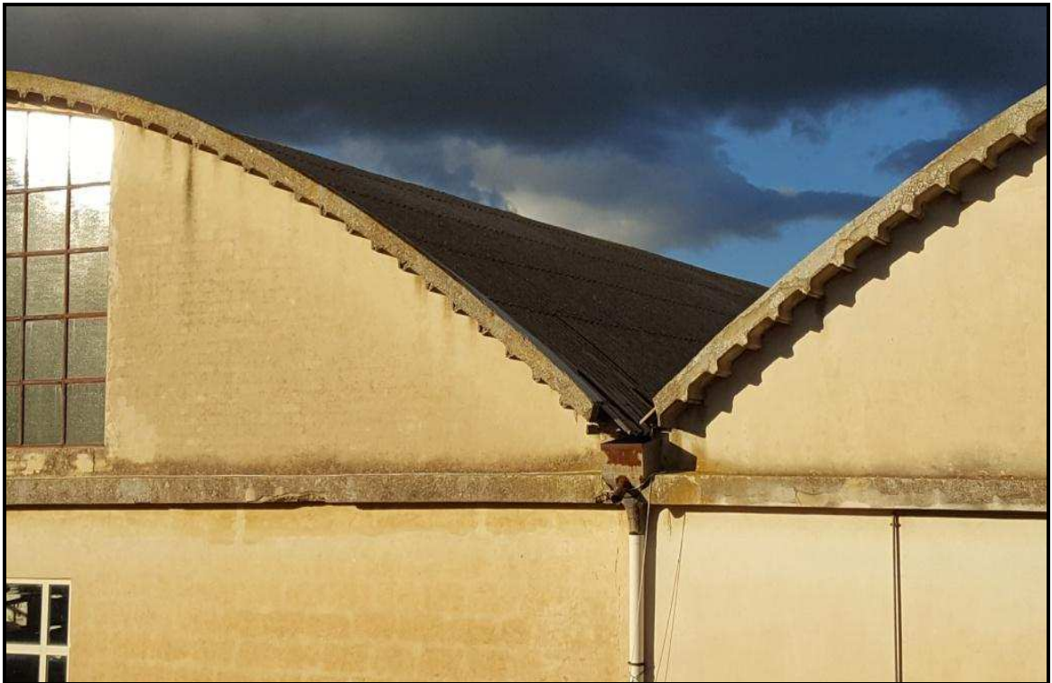
Foto v: copertura del 1° vano del cespite N°3.
