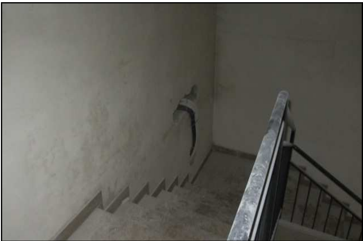
Foto p: vano scala cespite N°2 quota P.2°.
