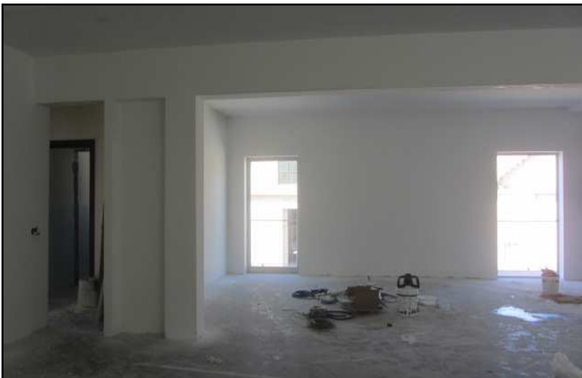
Foto n: interno P.1° cespite N°2 lato ovest.
