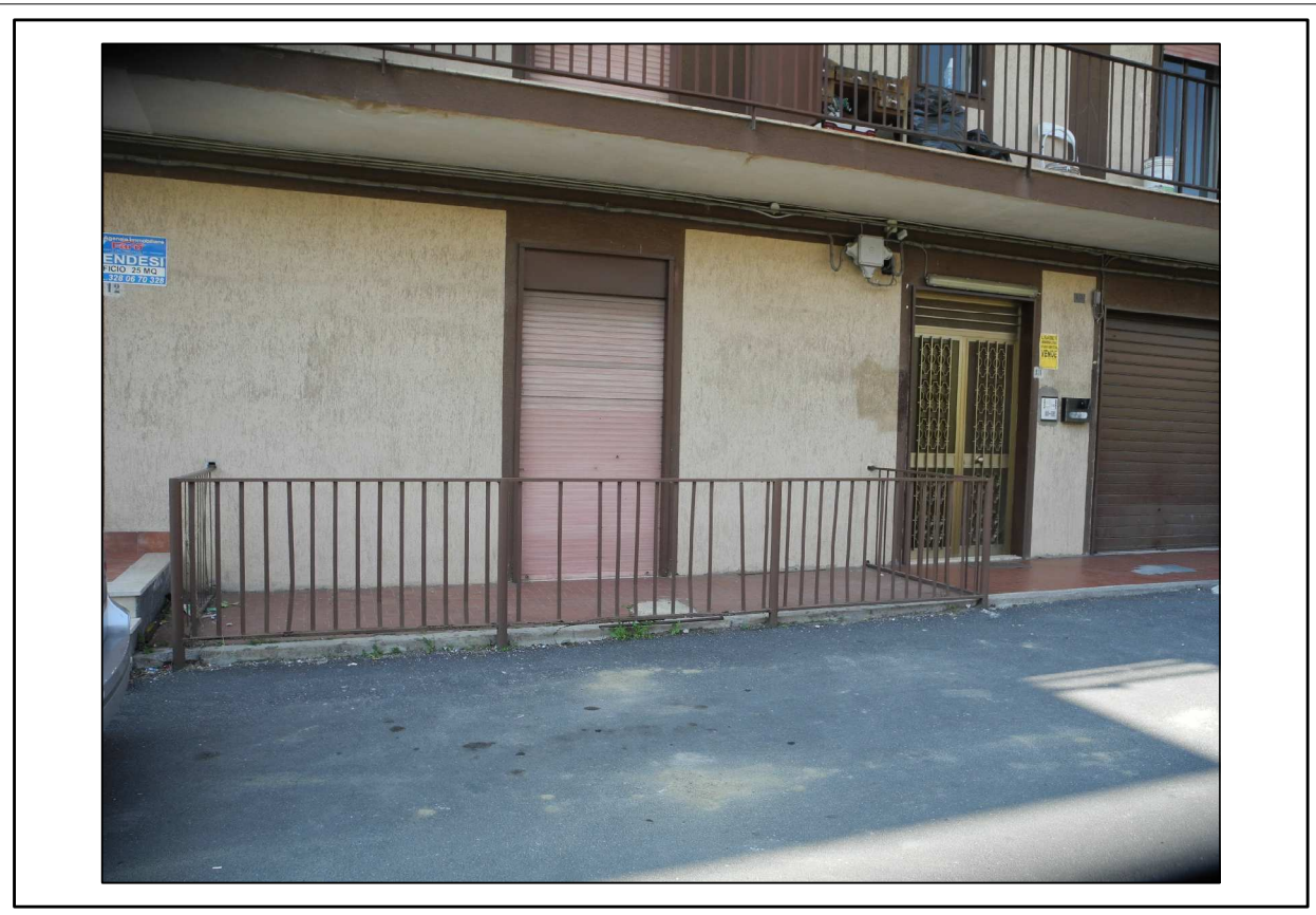
Descrizione: VISTA DA VIA DELLE CAMELIE - BALLATOIO 3
