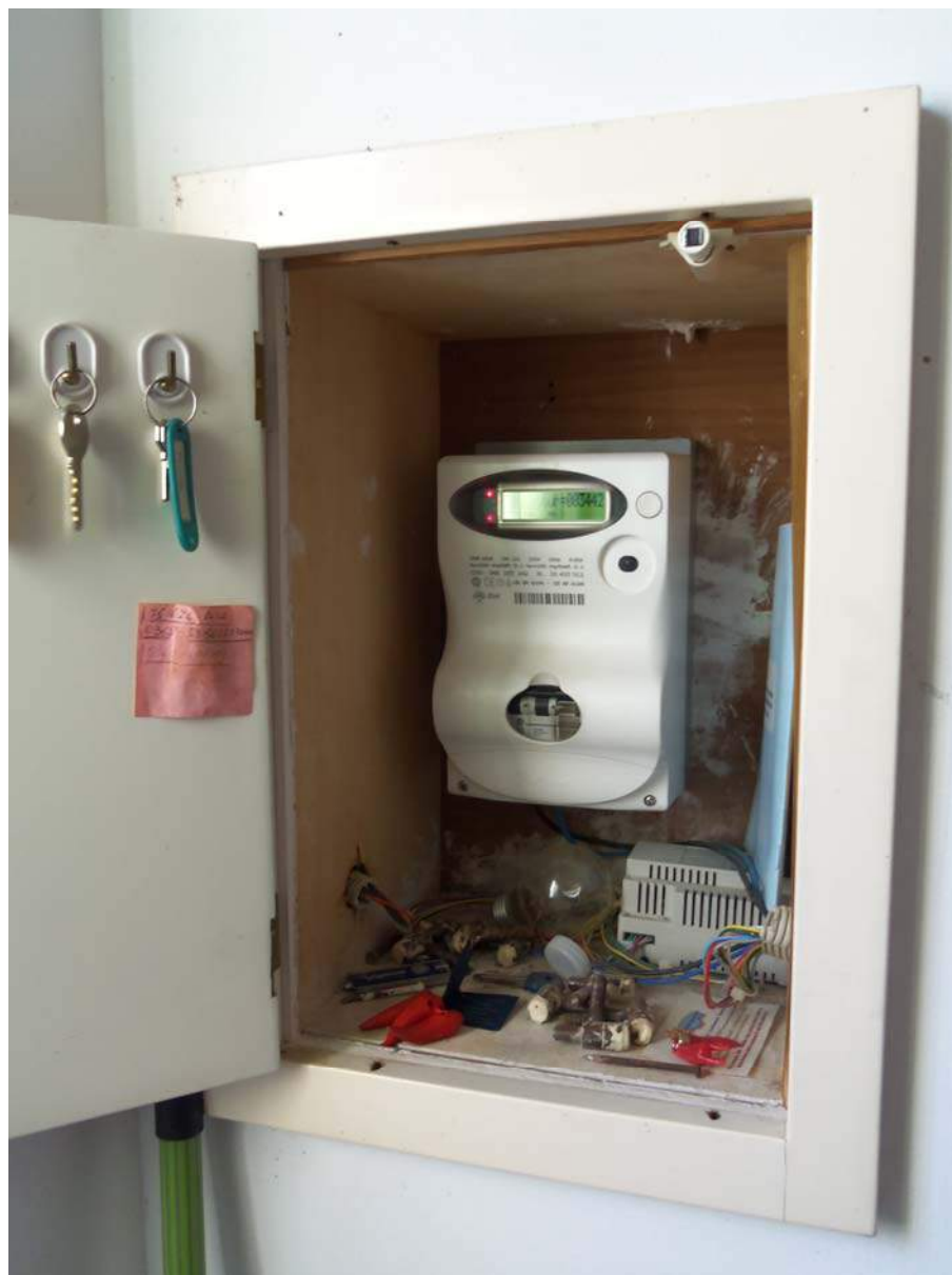
Foto n. 8 - Particolare del contatore e del quadro elettrico ubicati all'ingresso dell'immobile.
