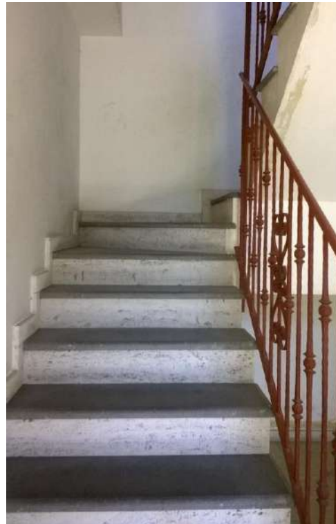
Foto 8 Vista del vano scala
