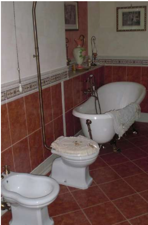
Foto 32 Vista del WC 2
