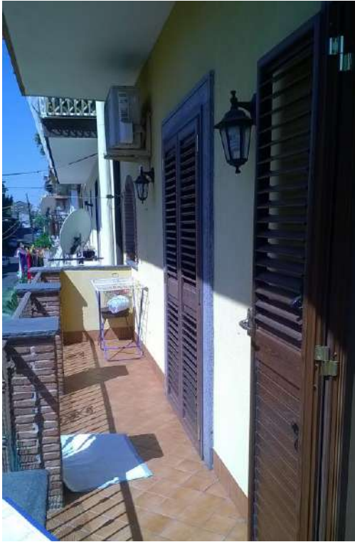
Foto 23 Vista del ballatoio Sud-Est
