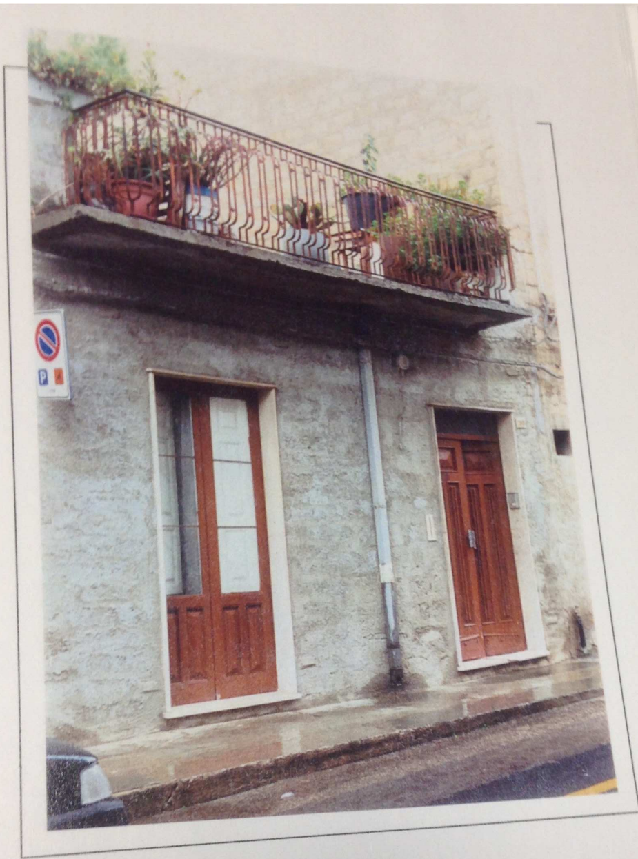
Foto n. 4: Prospetto su via Duca D'Aosta
