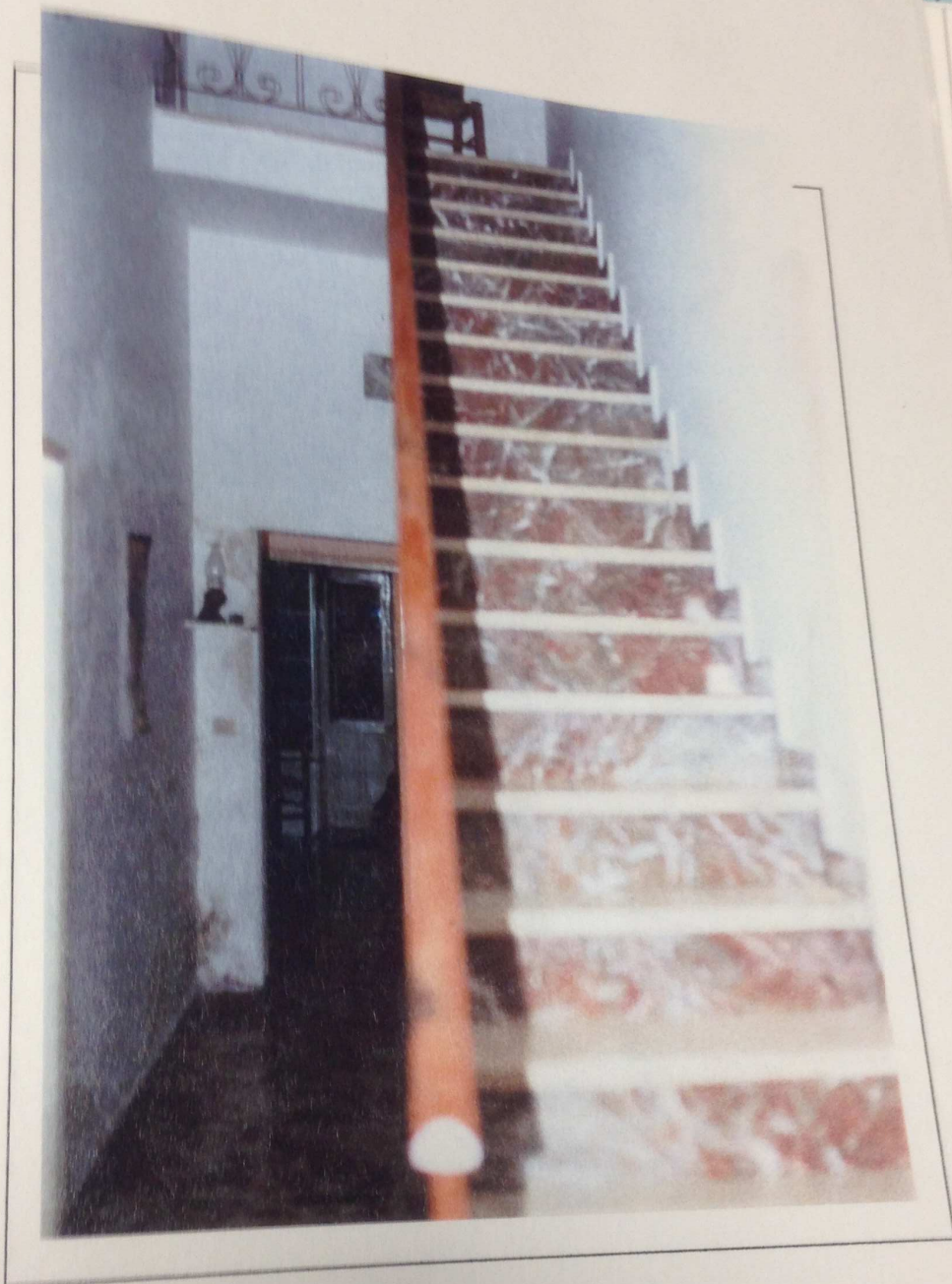
Foto n. 5: Scala di accesso alla terrazza di copertura
