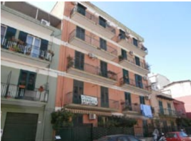
al centro - prospetto del fabbricato su via Stazzone sotto - portone e interno portineria
