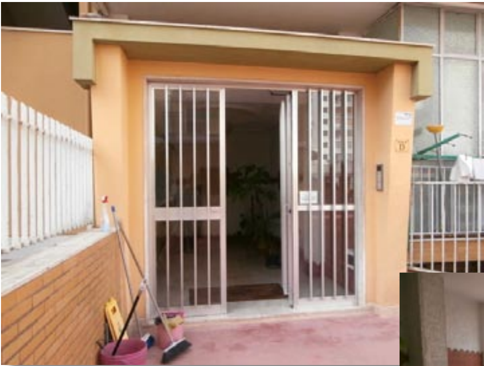
sopra - portone scala D accanto - interno portineria
