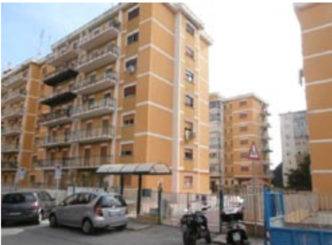
sotto - portineria e dettaglio prospetto interno fabbricato scala D
