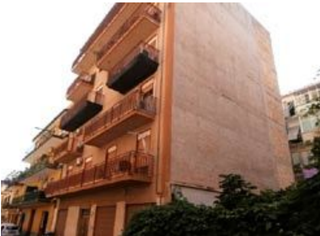
al centro - prospetto su via Redentoristi sotto - scorci degli altri prospetti (da definire)
