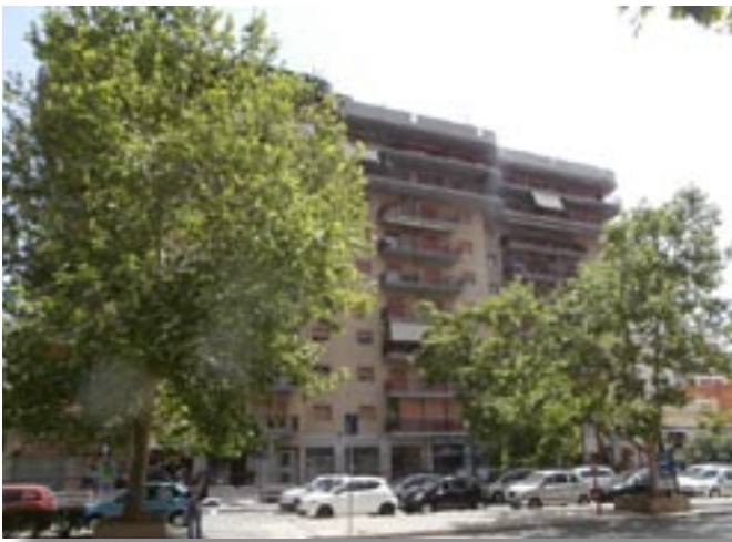
sotto - dettagli prospetto e vetrine negozio
