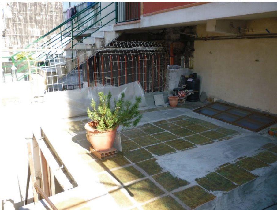
Foto 14: Terrazza di copertura posta sul vano cucina, lavanderia e servizio igienico:
