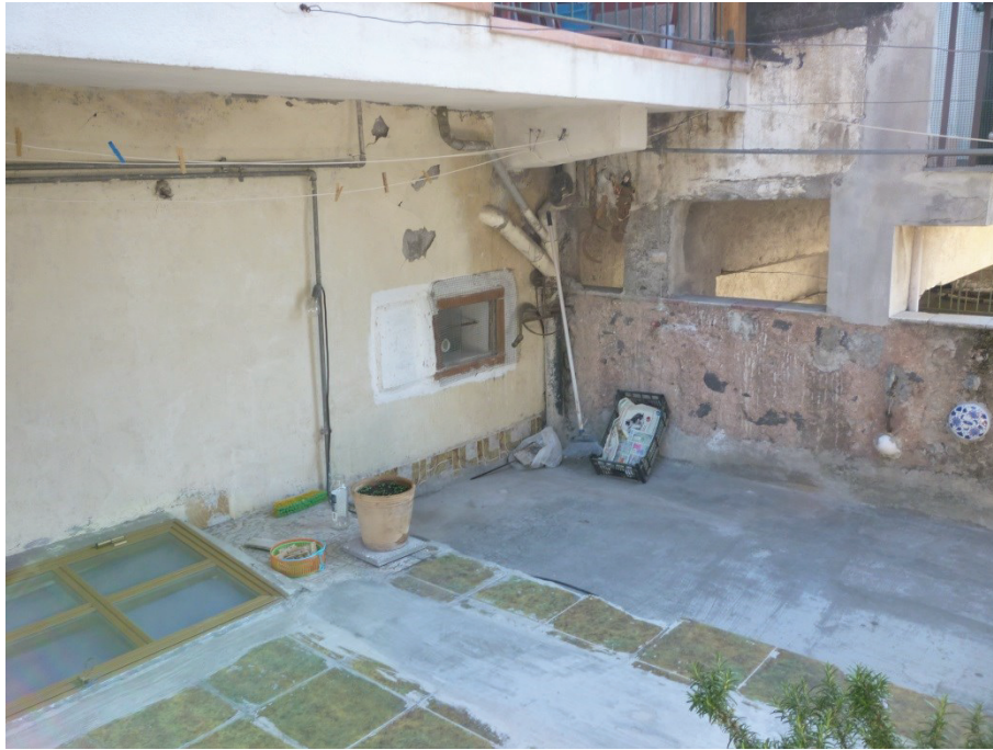
Foto 13: Terrazza di copertura posta sul vano cucina, lavanderia e servizio igienico:
