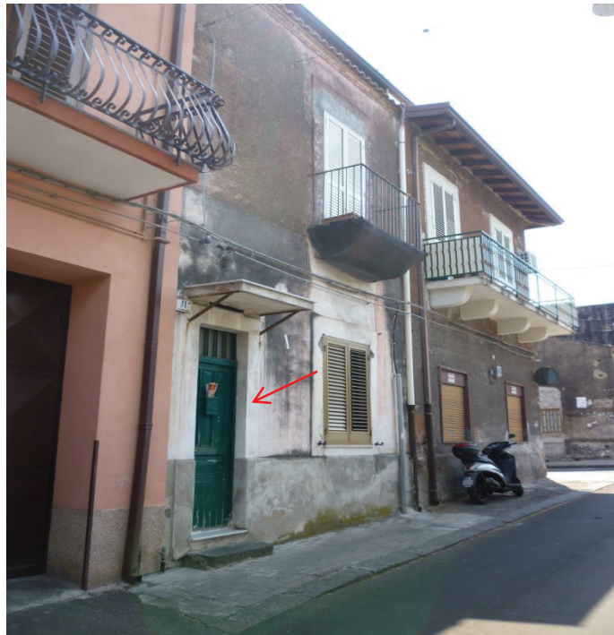
Foto 1 Prospetto su via Nino Bixio:
