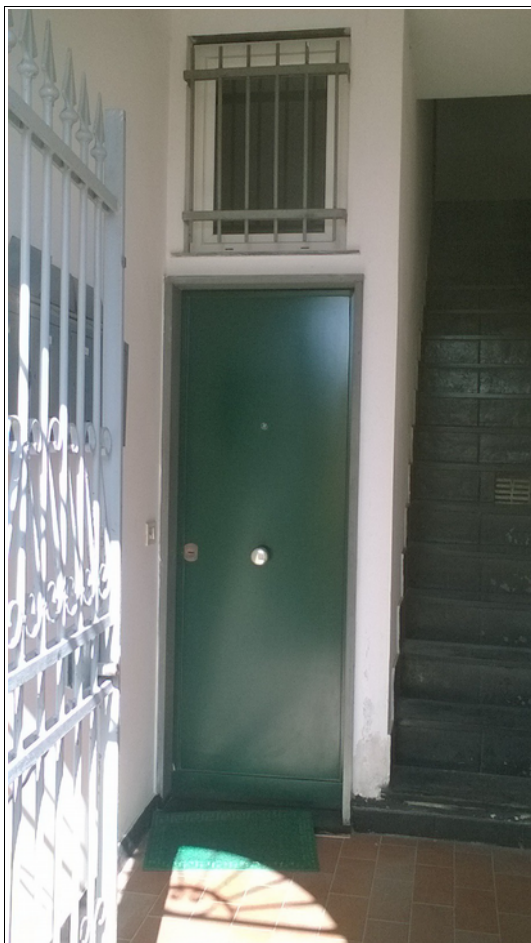
Androne ingresso int. 1A
